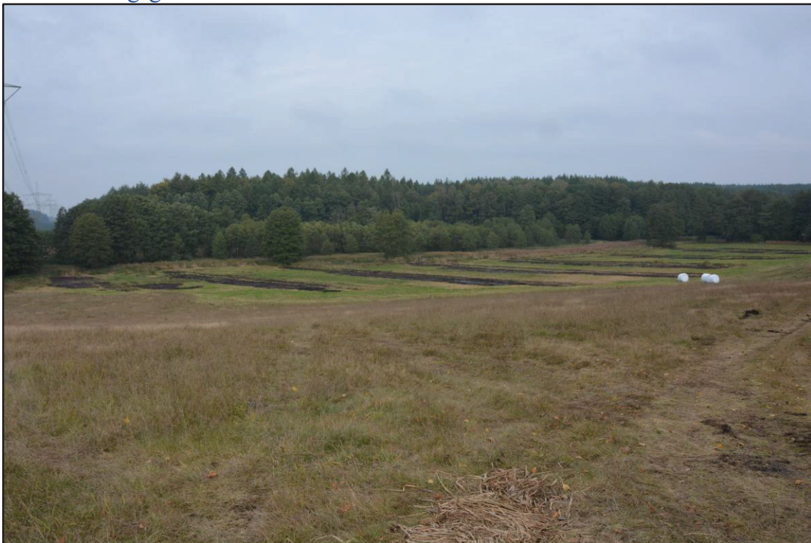
Abnahme Grabenverfüllungen I (Eigene Aufnahmen des StALU 2016)
