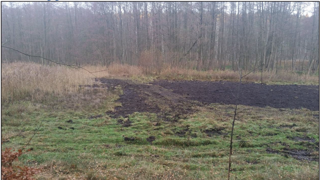
Abnahme Grabenverfüllungen I (Eigene Aufnahmen des StALU 2018)
