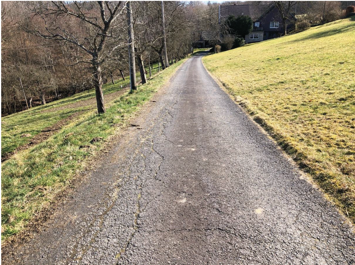
Abbildung 14: Asphaltierte Zuwegung zum Nachbarhof. (Eigene Aufnahme vom 15.03.25)
