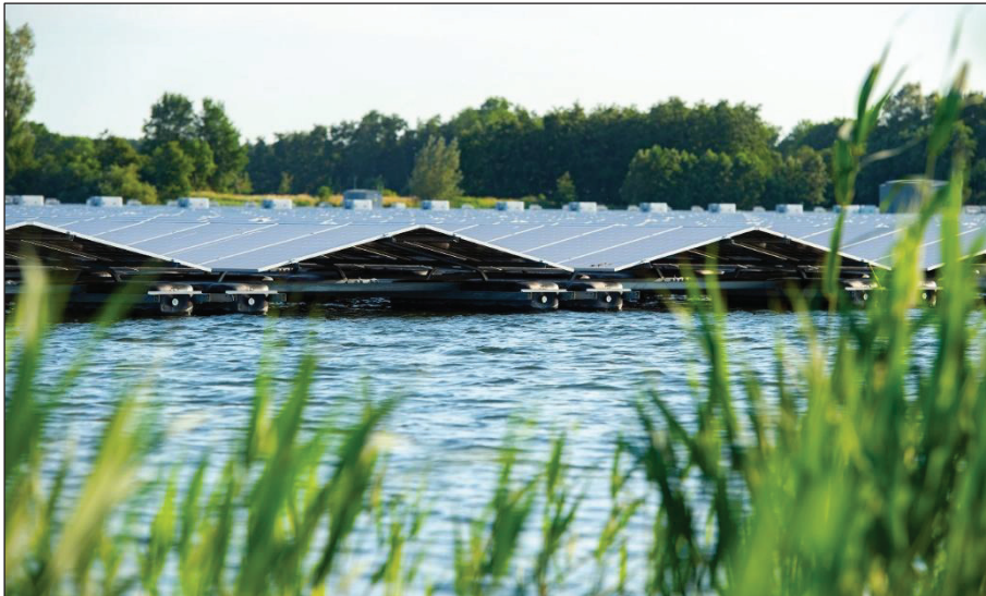
Abbildung 5: Symbolbild für eine schwimmende Photovoltaikanlage auf Pontons mit Aluminiumrahmen. Die Photovoltaikmodule sind in Ost-West-Richtung zur Sonne ausgerichtet. (Quelle: ZIMMERMANN PV-Floating, 2025)
