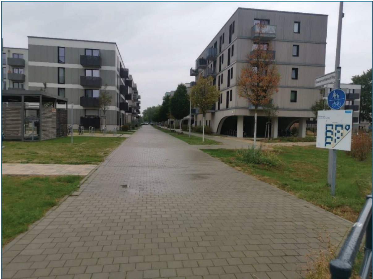
Abbildung 13: Blockrandzeilen des WA1 (links) und Punkthochhäuser des WA2 (rechts) getrennt vom Wohnweg Alexander-von-Humboldt-Weg, Blickrichtung Nordwest, Quelle: Eigene Aufnahme am 02.10.2024.
