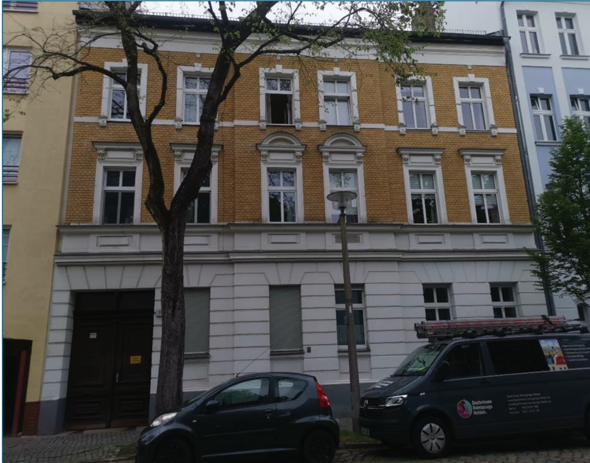
Abbildung 20: Gründerzeitlicher Geschosswohnungsbau der Friedenstraße 17 in 12489 Berlin Adlershof, Quelle: Eigene Aufnahme am 21.04.2025.
