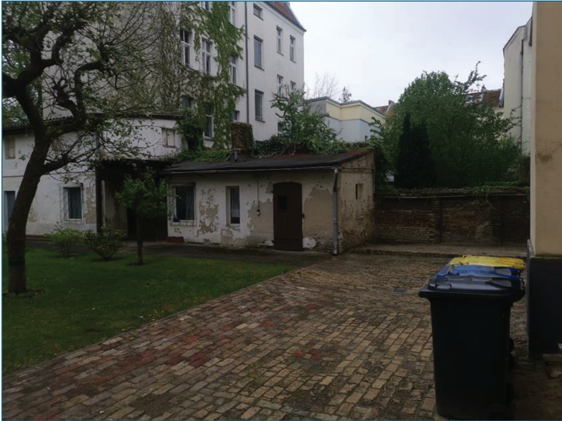
Abbildung 21: Hof und Nebengebäude des Gebäudes in der Friedenstraße 17 in 12489 Berlin Adlershof, Quelle: Eigene Aufnahme am 21.04.2025.
