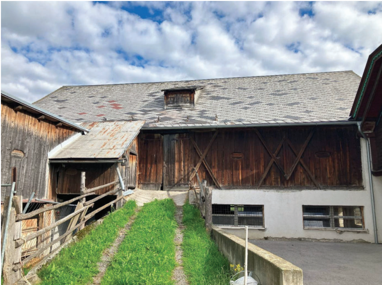
Abb. 5: Ansicht der südlichen Traufseite vom Stall. Eine Rampe mit hölzernem Geländer führt hinauf zum Eingang. Rechts der Rampe befindet sich ein kleiner betonierter Platz
