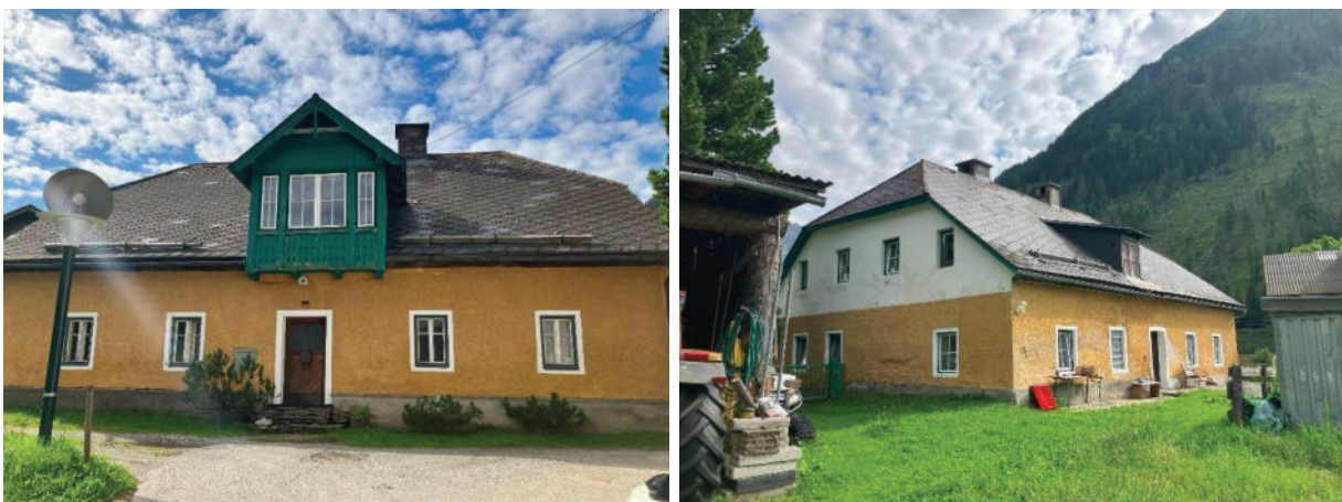
Abb. 2: Links das Wohnhaus von Bauer A. mit Blick auf die Traufseite mit Haustür; Rechts die Ansicht der West- und Südwand. Die Vegetation vor dem Haus wirkt frisch
