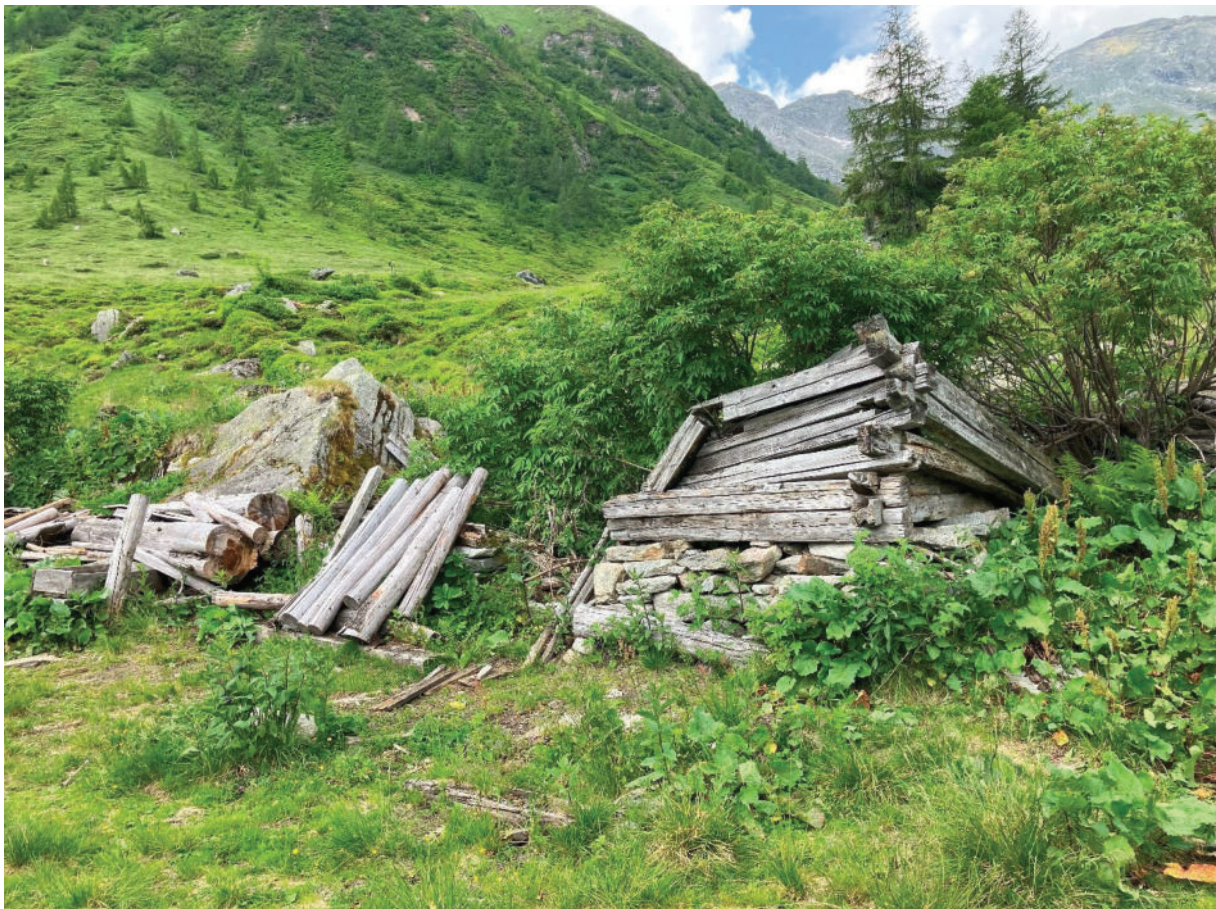
Abb. 36: Blick nach Südwesten auf die Ruine des Jungviehstalls (vgl. auch Abb. 13). An der rechten Bildseite kann man Flächen mit Almampfer sehen, dahinter steht wieder Roter Holunder
