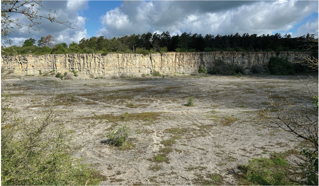
Abbildung 8: Aufgelassener Steinbruch mit bis zu 12 m hohen, annähernd senkrechten Abbruchwänden; gegenwärtig als Deponiestandort genutzt (Juni 2024).
