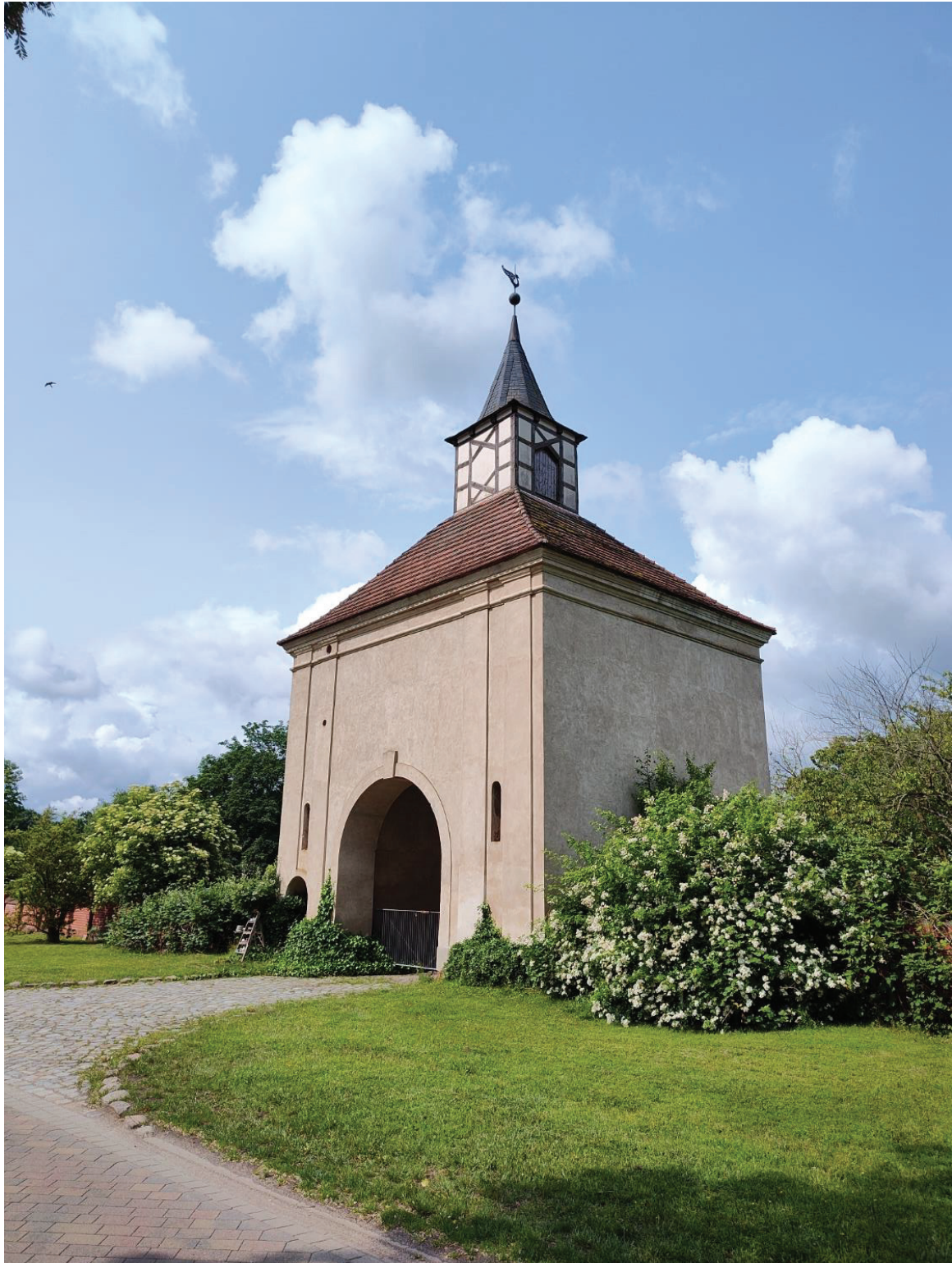
Abb. 22: Torhaus des Groß Vieler Gutshauses
