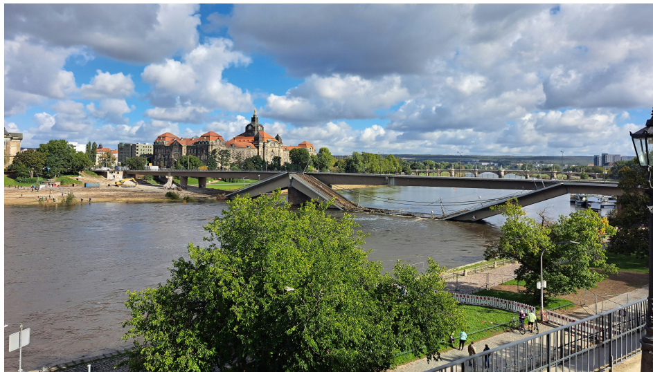
Abbildung 1.2: Am 11.09.2024 teilweise eingestürzte Carolabrücke in Dresden [Bybbisch94, 2024]
