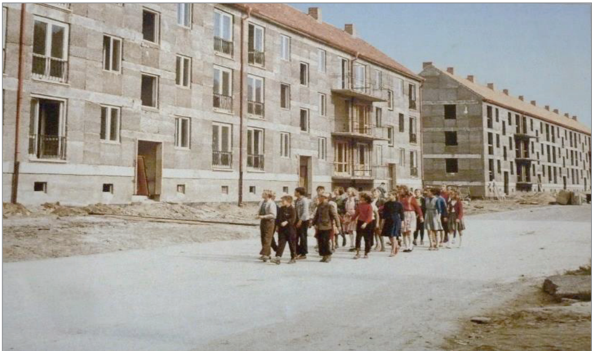
Abbildung 7: Die Zeilen der Clara-Zetkin-Straße im Rohbau-Zustand. Die neue Blockbauweise lockte nebst Fachpersonal auch ganze Schulklassen an ihren Wandertagen an. Quelle: Milster 2000, S. 45.
