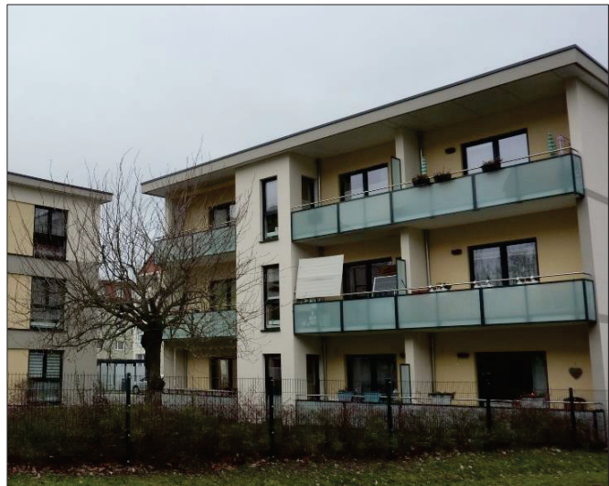
Abbildung 14: Auch im Erdgeschoss besteht kein direkter Zugang nach draußen. Quelle: Eigene Aufnahme.
