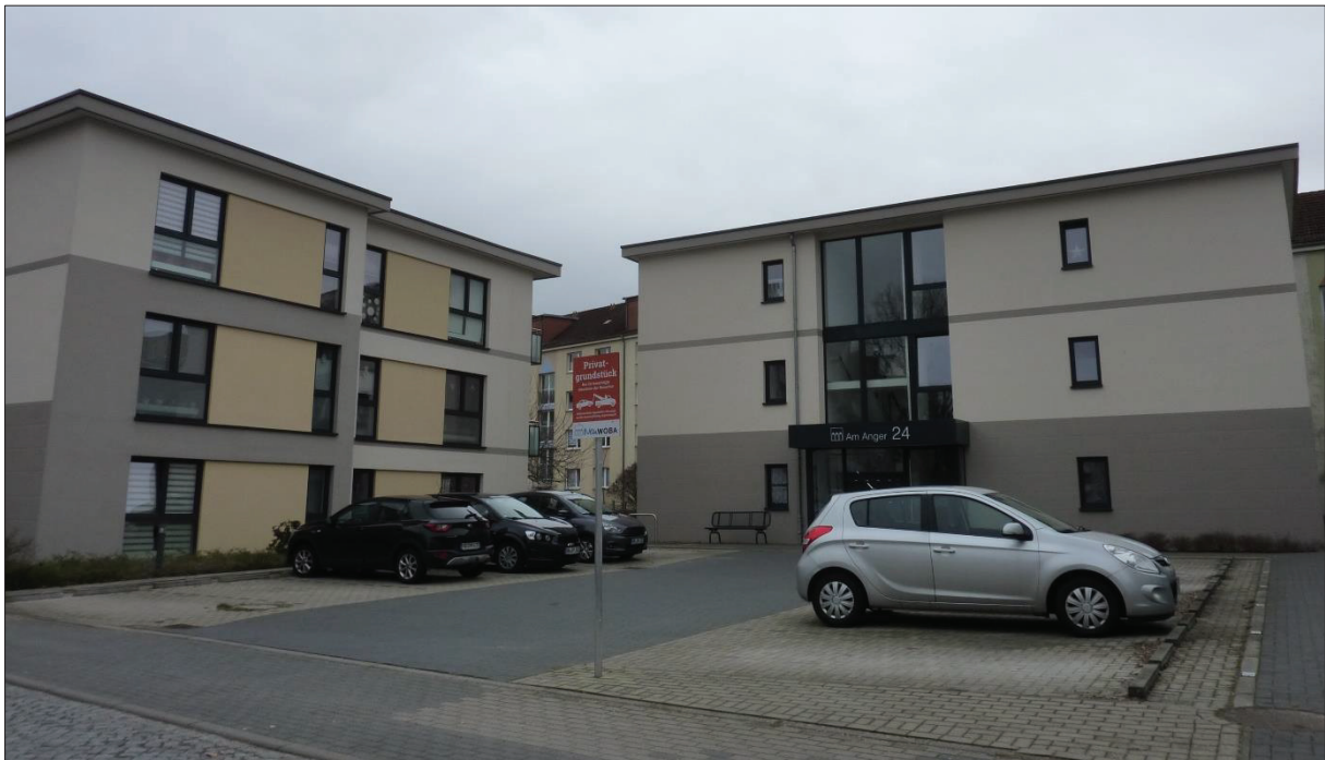
Abbildung 13: Das verglaste Treppenhaus reicht über die gesamte Höhe der Hausfront. Die Mittig durch die Fenster laufende Querriegel und das vorstehende Flachdach sind ebenso zu erkennen wie der Bruch in der Linie der seitlichen Hauswand nach innen, der sich auch in den Wohnungsgrundrissen wiederfindet. Quelle: Eigene Aufnahme.
