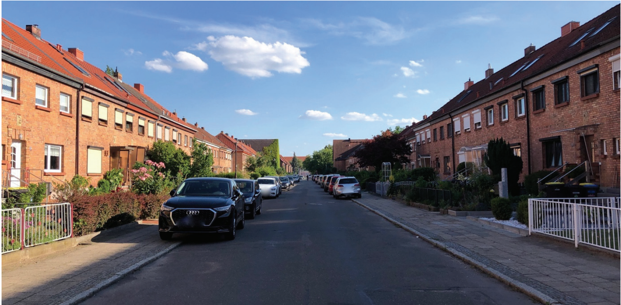
Abbildung 24: Blick in die Neuenkirchener Straße in Richtung Burgholzstraße. Die vorderen Parzellengrenzen werden individuell als Zaun oder Hecke hergestellt, können aber auch fehlen. Quelle: Eigene Aufnahme aus Juli 2023.
