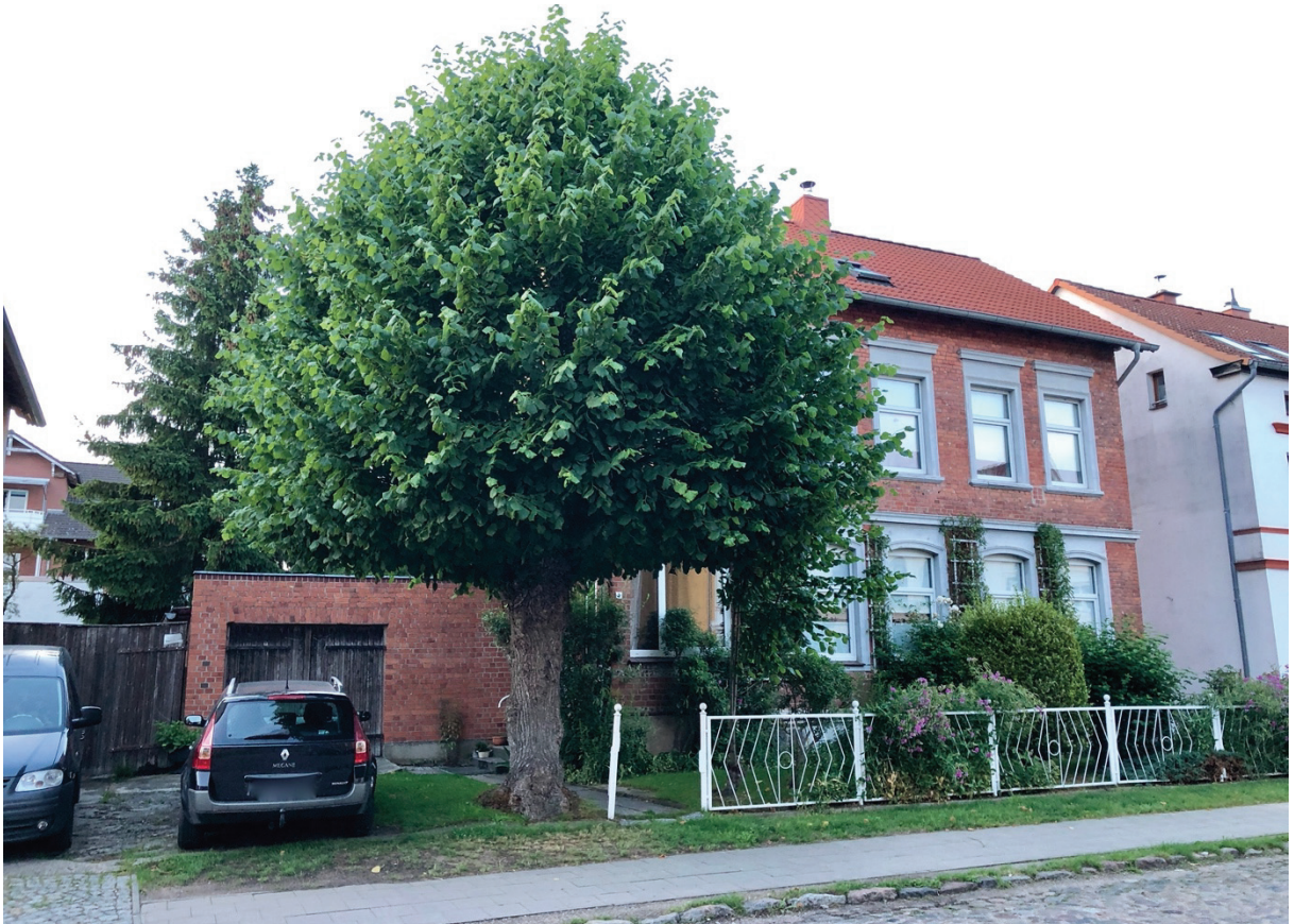
Abbildung 21: Gründerzeitliches Geschosshaus in der Voßstraße ohne Tor und Pforte. Der Zaun hat keinen Sockel und wird entlang des Fußweges zum Eingang nicht weitergeführt. Ein einsamer Zaunpfeiler und eine Reihe Betonplatten in Verlängerung des noch bestehenden Zauns deuten darauf hin, dass es hier einst eine Pforte gab und der heutige PKW-Stellplatz (wahrscheinlich mit Tor) eingefriedet gewesen sein könnte. Quelle: Eigene Aufnahme aus Oktober 2023.
