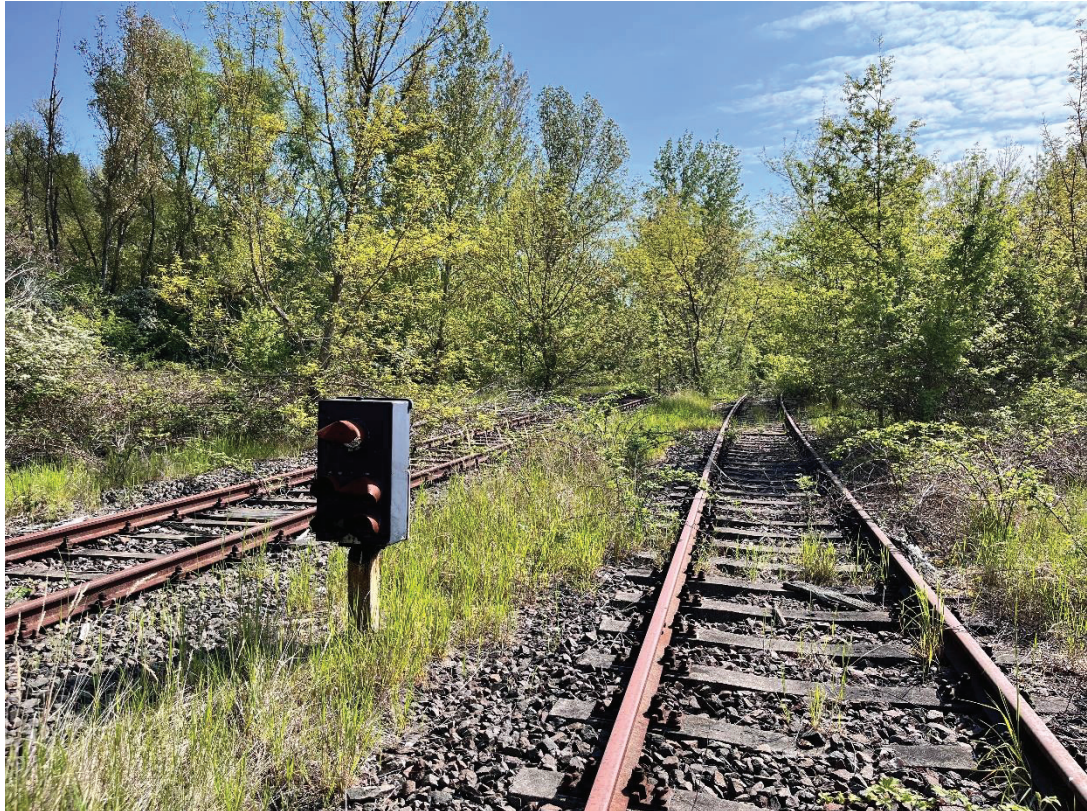
Rückzubauende Gleise im nördlichen Bereich des Bahnhofs, eingerahmt durch Gehölzaufwuchs jungen bis mittleren Alters
