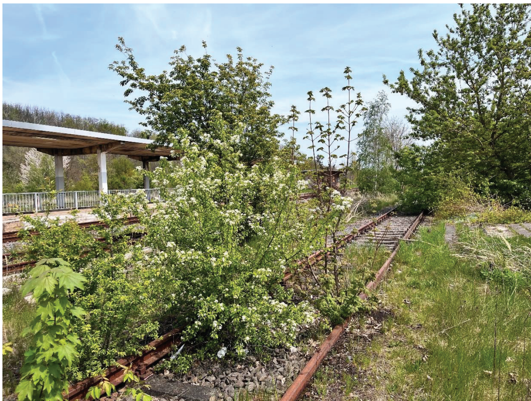
Rückzubauende Gleise südlich des Bahnsteiges (Gleis 1 und 2) bewachsen durch junge Gehölze
