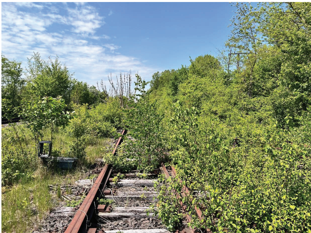
Rückzubauende Gleise im nördlichen Bereich des Bahnhofs bewachsen durch Gebüschgruppen
