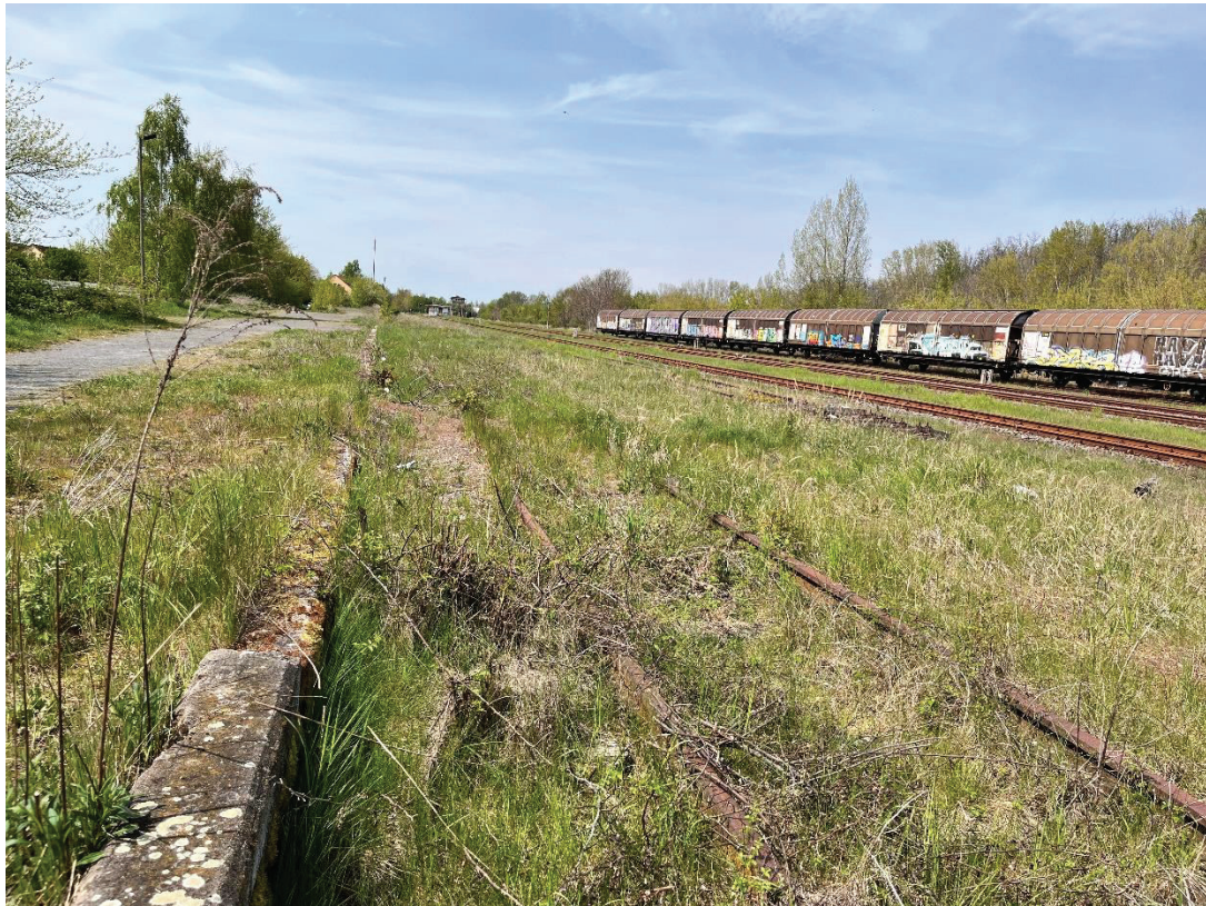
Rückzubauende Gleise im südlichen Bereich des Bahnhofs (Gleis 1 und 2)
