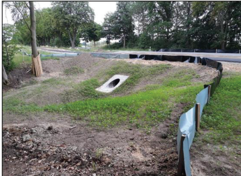
Abbildung 1: Neuerrichteter Entwässerungstunnel mit Amphibienschutzzaun bei km 1,184 (M. Kliemt 22.06.2021).
