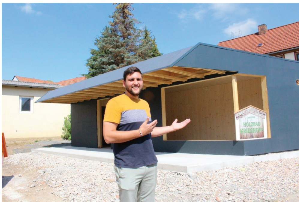
Abbildung 11: Baustelle für den Gesundheitskiosk in Kirchheilingen im Juli 2022
