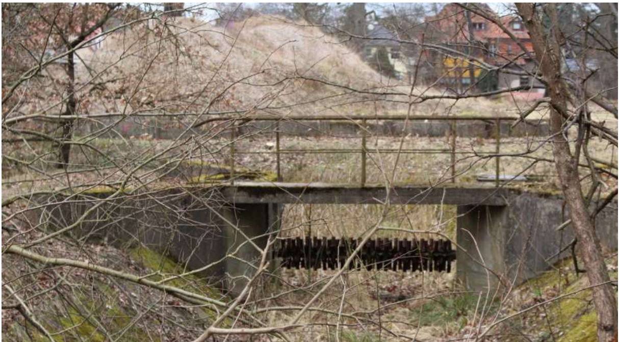
Ehemalige Kläranlage: größtenteils Beton, Eisen und Klinkermauerwerk
