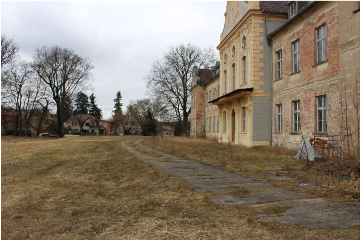
Wegeführung um das Schloss: veraltete, teils überwachsene, schadhafte Betonplatten, Plattenbelag uneben
