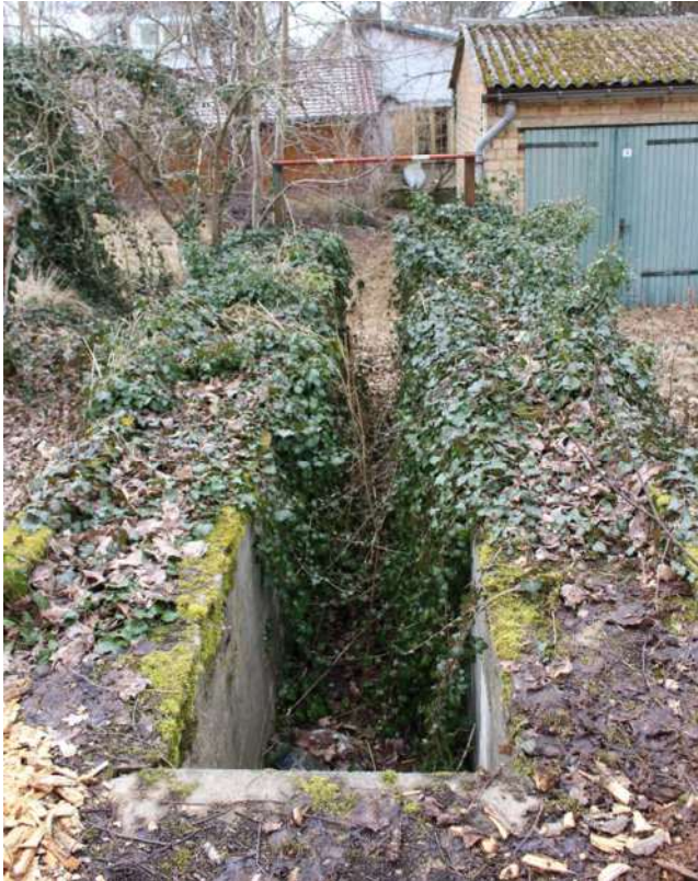
Nebengebäude (Garagen und Sonstiges): Betonwände mit Efeubewuchs
