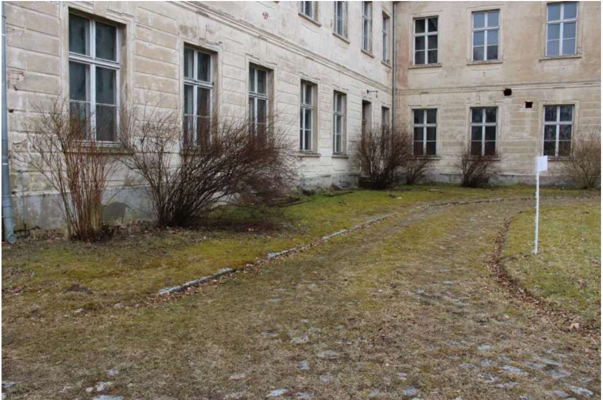
Vegetationsfläche am Schlossgebäude: vergreiste Sträucher, zu dicht am Gebäude gepflanzt
