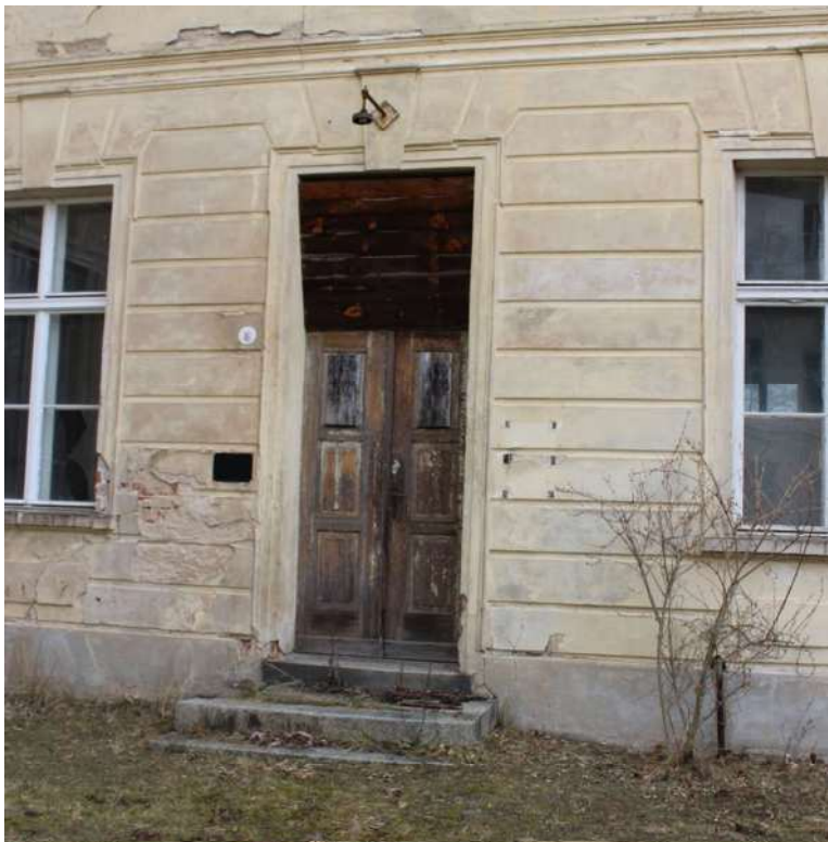
Eingang östl. Seitenschiff: Stufen aus Naturstein (Granit, grau) und Beton
