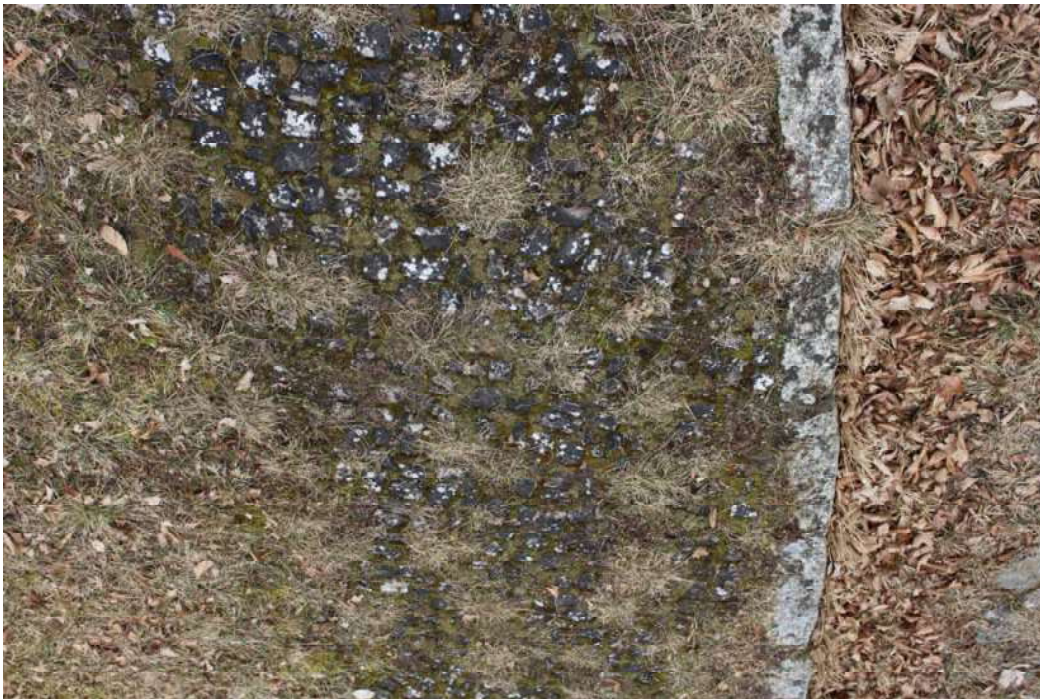
Zuwegung für Fußgänger: stark vermoostes, überwuchertes und verfärbtes Kleinsteinpflaster (Basalt)
