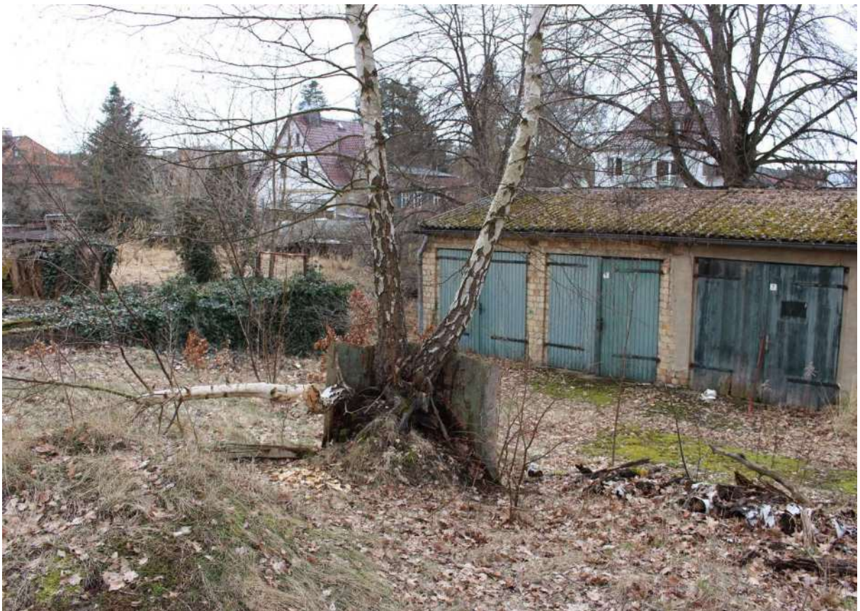
Ehemalige Garagen (Klinkermauerwerk, teilweise verputzt; Doppelflügeltor aus Holz und Wellplatten)
