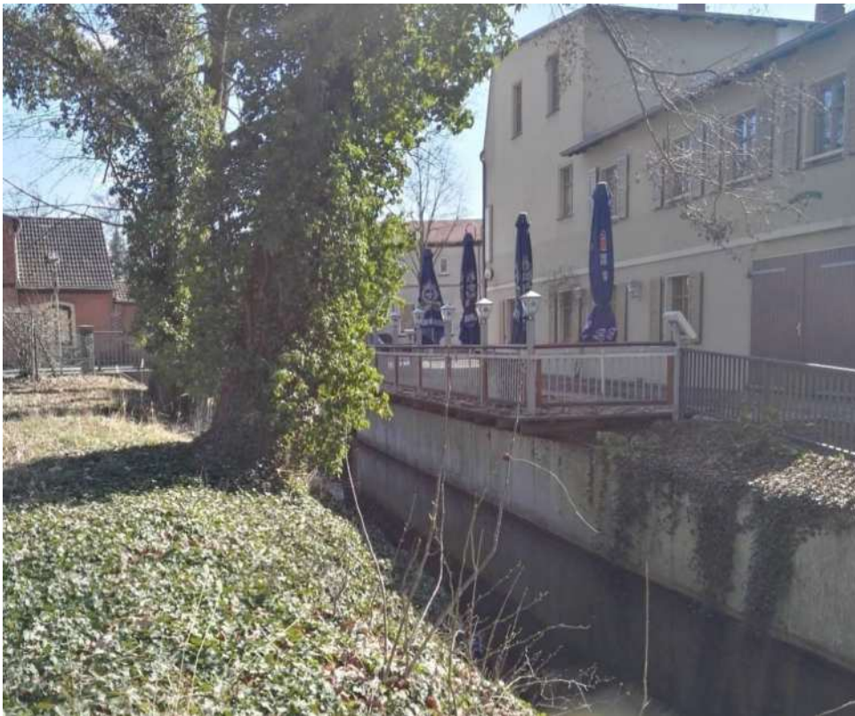
Südl. Ufer (Schulhavel): Betonwand zur Begradigung der Böschung entlang des Flusslaufs im östlichen Bereich
