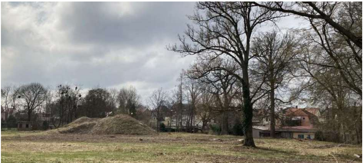
Schutthügel: Bauschutt, wahrscheinlich entstanden bei der Entkernung des Schlossgebäudes
