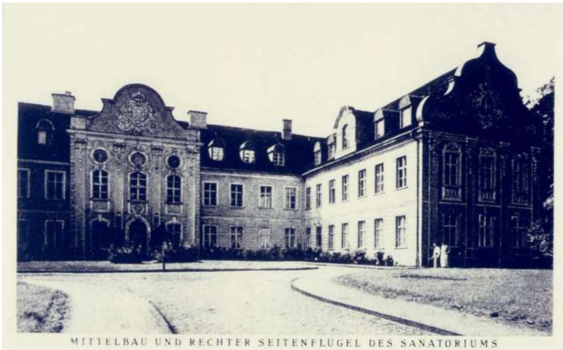
Abbildung 14: „Mittelbau und rechter Seitenflügel des Sanatoriums“; um 1925 (Quelle: „Sanatorium Schloss Fürstenberg-Fürstenberg in Mecklenburg“, aus dem Stadtarchiv Fürstenberg/Havel)
