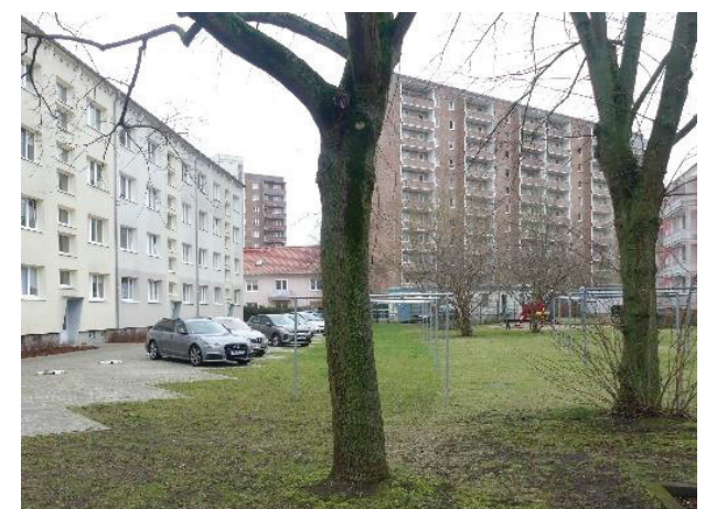
Abb. 30: Nr. 12: Östlicher Innenhof
