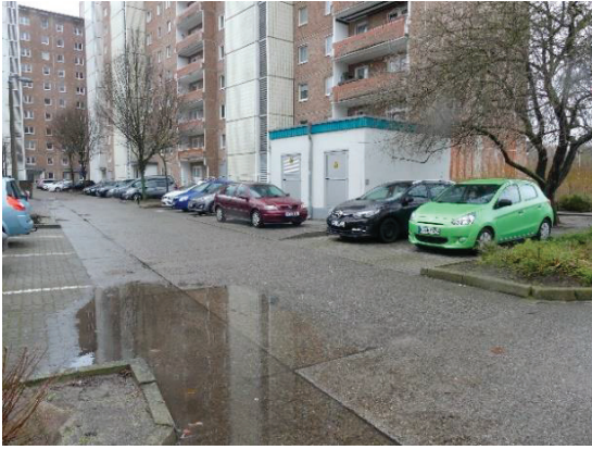
Abb. 19: Nr.1: Nördlicher Innenhof
