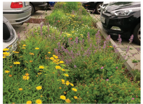
Anhang 18: Versickerungsmulde mit trockenheitstoleranten Wildstauden bepflanzt (SCHAU- UND SICHTUNGSGARTEN HERMANNSHOF E.V.9, o.J.)
