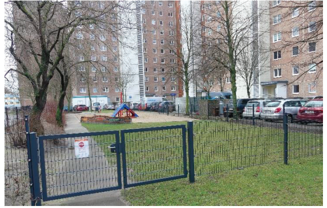
Abb. 20: Nr.2: Nördlicher Innenhof
