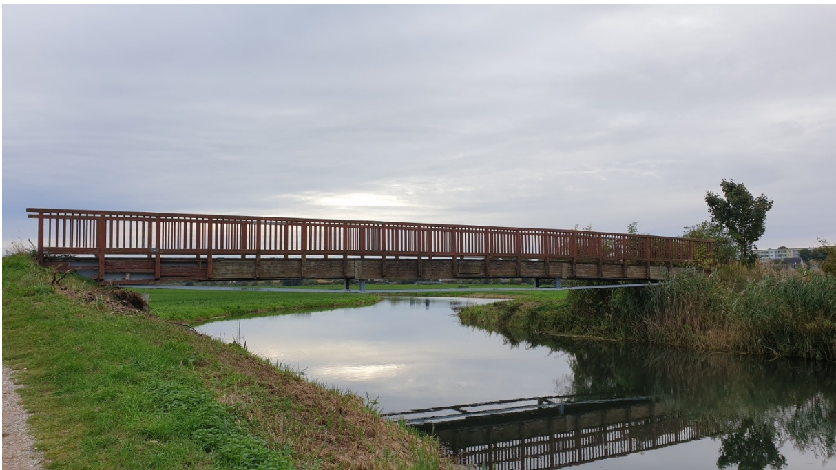
Abbildung 5-1: Fußgängerbrücke über die Tollense
