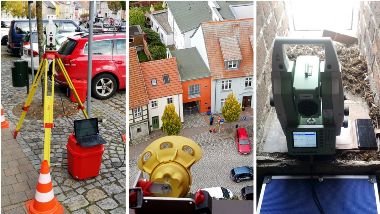
Abbildung 4-5: Richtungsmessung vom Leica TS30 zum GPR112-Prisma und Leica TM30 für Neigungsmessung
