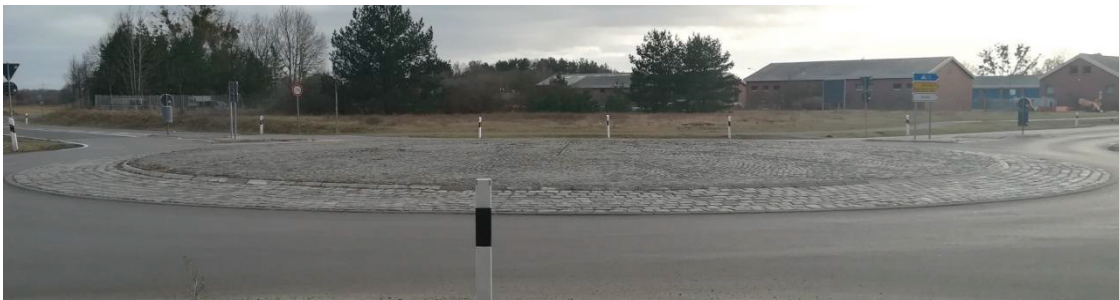
Abb. 42 Nahaufnahme Mittelinsel, Blickrichtung zur Straßenmeisterei (Woldegker Chaussee / B96)
