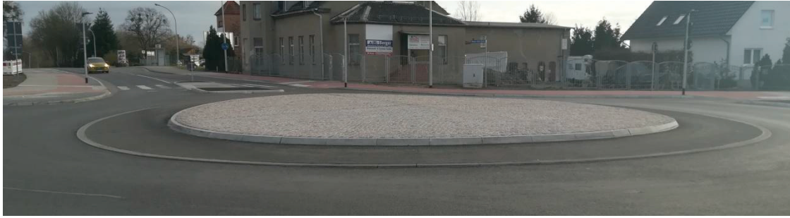
Abb. 45 Nahaufnahme Mittelinsel, Blickrichtung aus der Strelitzer Chaussee (Wesenberger Chaussee / Woldegker Chaussee)
