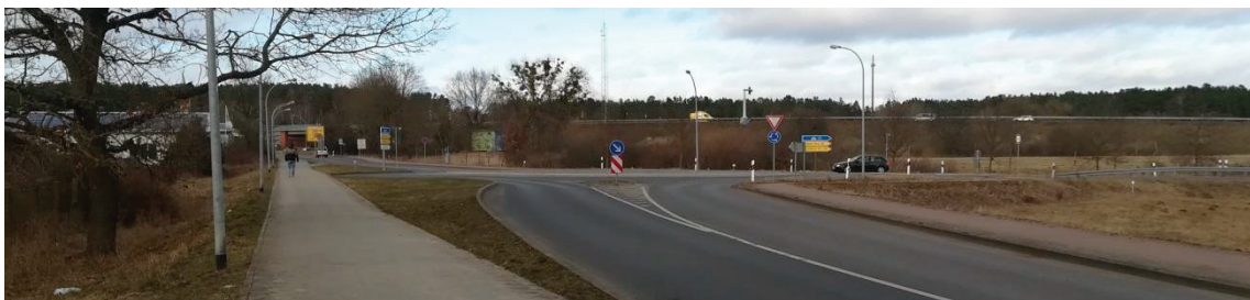
Abb. 49 Blick auf den Kreisverkehr aus der Richtung Carl-Meier-Straße aus Strelitz-Alt kommend (Carl-Meier-Straße / B96)
