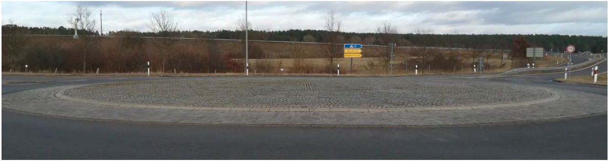
Abb. 48 Nahaufnahme Mittelinsel, Blickrichtung gegenüber der Zufahrt von der B96 (Carl-Meier-Straße / B96)
