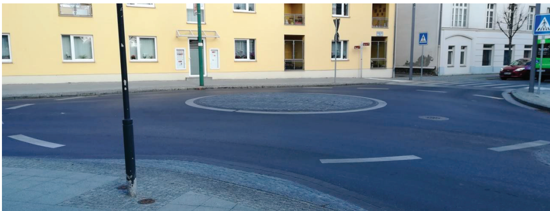
Abb. 14 Nahaufnahme Mittelinsel aus Blickrichtung der Semmelweisstraße (Zierker Straße)
