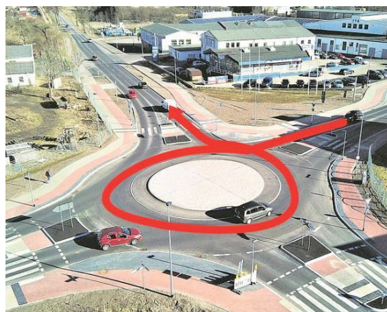
Abb. 44 Vogelperspektive, Nordkurier [roter Pfeil Anm. des Urhebers] (Wesenberger Chaussee / Woldegker Chaussee)
