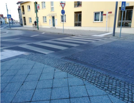
Abb. 16 erhöhter Zebrastreifen aus Richtung Innenstadt kommend (Zierker Straße)
