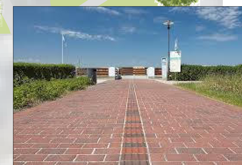
Roter Pflasterklinker mit zentraler Pflasterlinie
