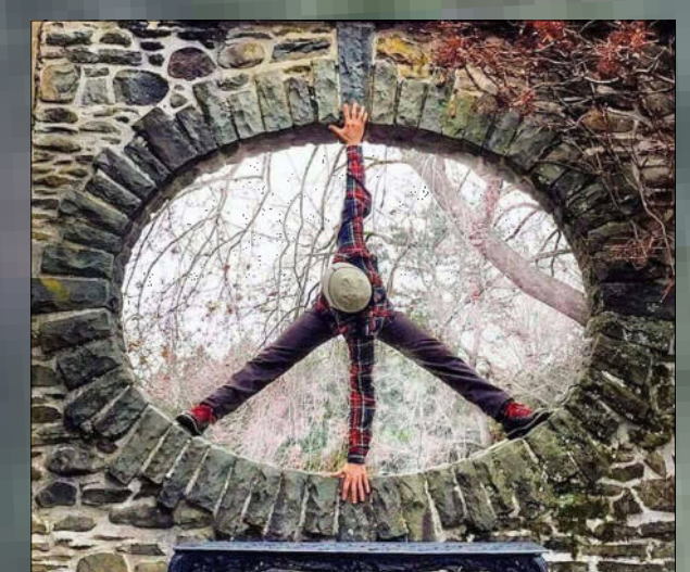
Mauerbogen im nördlichen Teil
