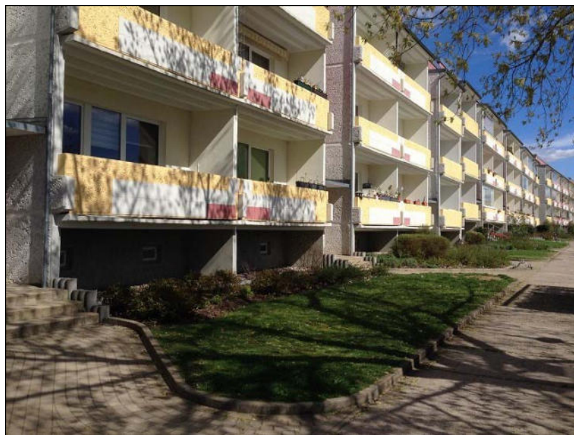
Abb. 24 Eingangsbereich in der Straße Uns Hüsung
