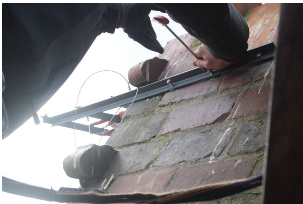
Abbildung 3.7: Anbringen der Antennenhalterung
