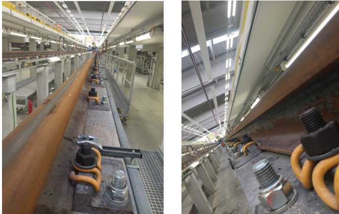
Abbildung 5: Oberkonstruktion (Rippenplatte mit Schiene)
