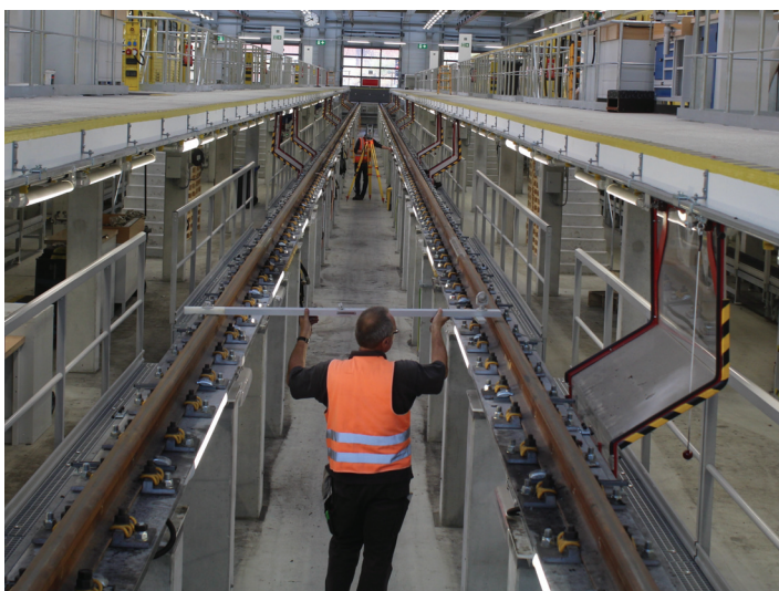
Abbildung 11: Messung mit Gleismesslatte
