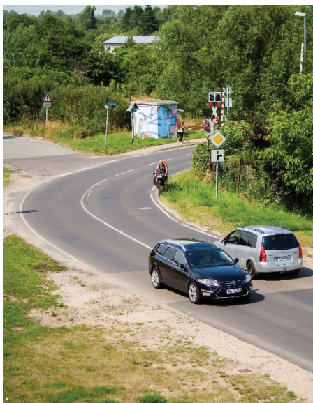
Abb. 31: Gefahrenpotential durch fehlende Wege und einen schlecht einsehbaren Kurvenbereich
