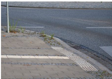
Abb. 26: Falsch verlegtes Sperrfeld
