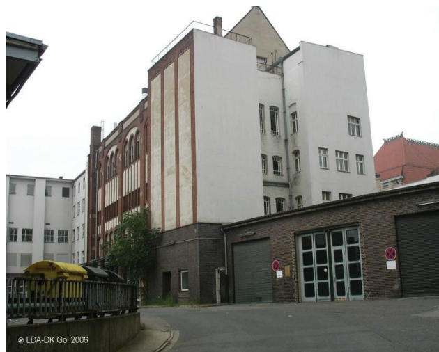
Abbildung 13: Das ehemalige Fernmeldeamt von Norden betrachtet (Quelle: (32))
