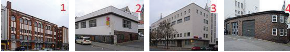
Abbildung 12: Die einzelnen Gebäudeteile in der Frontansicht (Quelle: (22))
