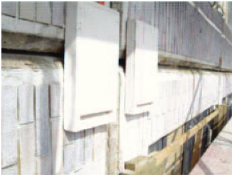
Abb. 12: Während der Sanierungsarbeiten werden die Fledermaus-Einlaufblenden vor den alten Quartieren montiert.
