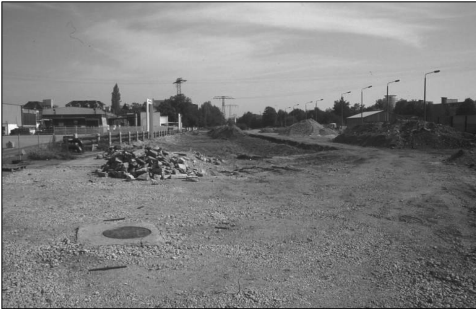
Abb. 17: Fläche des ehemaligen Kohlebahnhofs während der Entsiegelungsmaßnahmen
