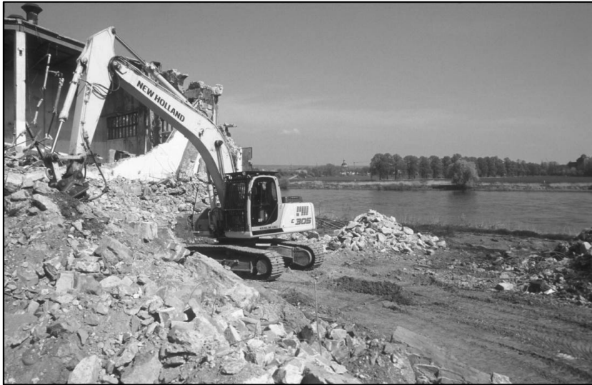
Abb. 21: Abriss der Hallen der Übigauer Werftanlage Foto: G. GÜLZOW
