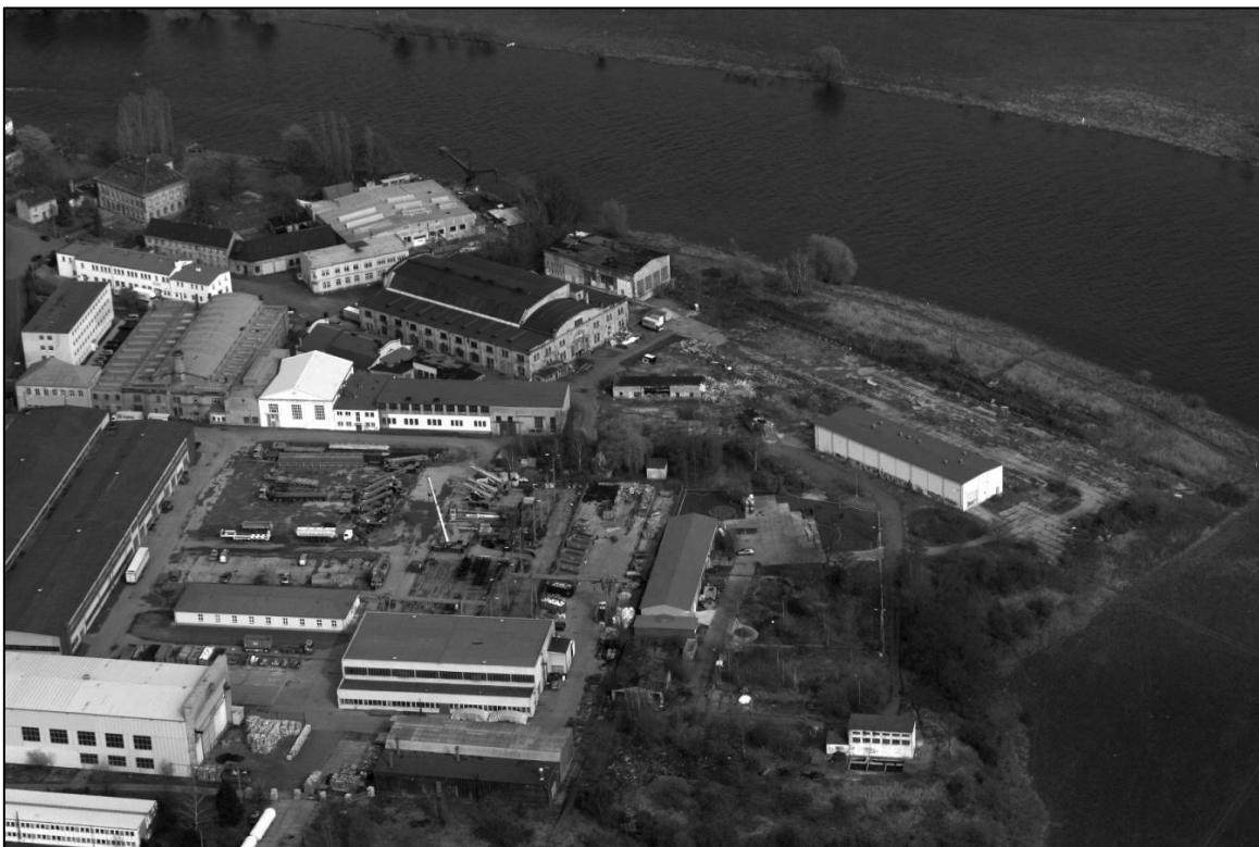
Abb.20: Luftbild der ehemaligen Werftanlage während des Abrisses der Produktionshallen
