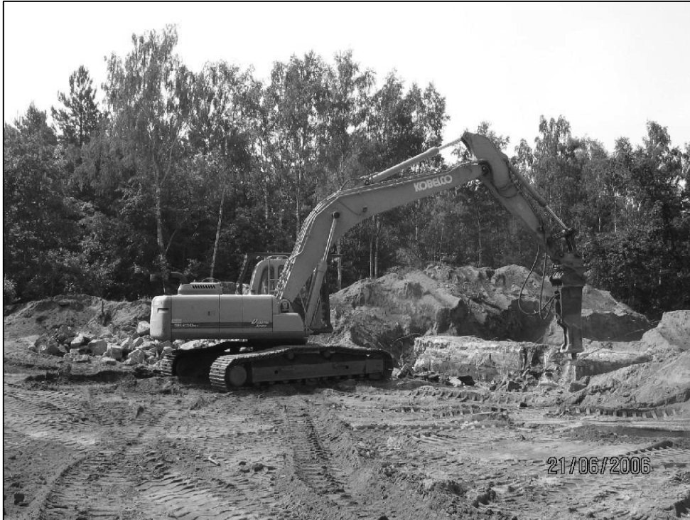
Abb. 8: Entsieglungsarbeiten auf einem der ehemaligen Parkplätze des Militärgeländes
