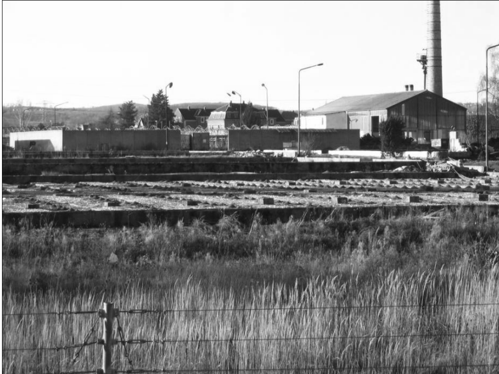
Abb.14: Frisch abgerissene Gewächshäuser der Gärtnerei im Herbst 2006
