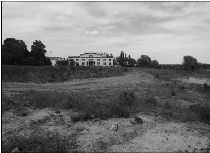
Abb. 22: Entsiegelte Fläche der Werftanlage Foto: K. BÖRTITZ
