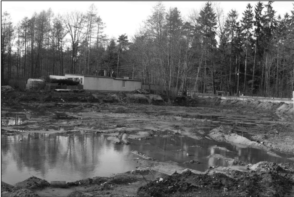
Abb. 11: Ausgleichsfläche „Ehemaligen Reichsarbeitsdienstbaracke“ nach der Abgrabung des Betonfundaments
