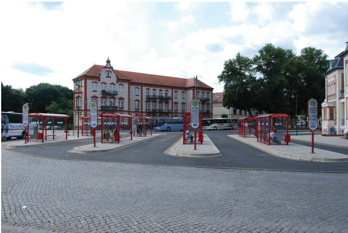
Abb. 32: Blick auf die Bussteige mit dem zu geringen Abstand von Fahrgastunterstand zur Bussteigkante
