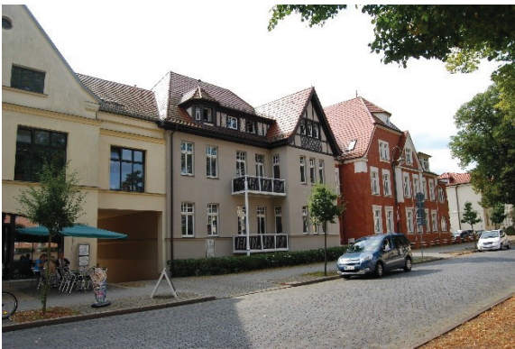
Abb. 17: Bebauung in der Marienstraße
