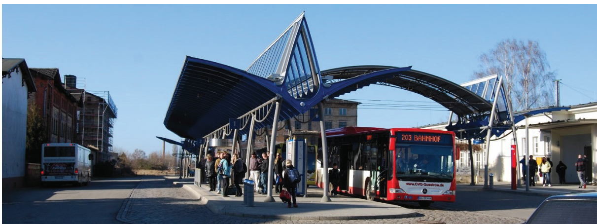
Abb. 33: Überdachter Busbahnhof in Güstrow
