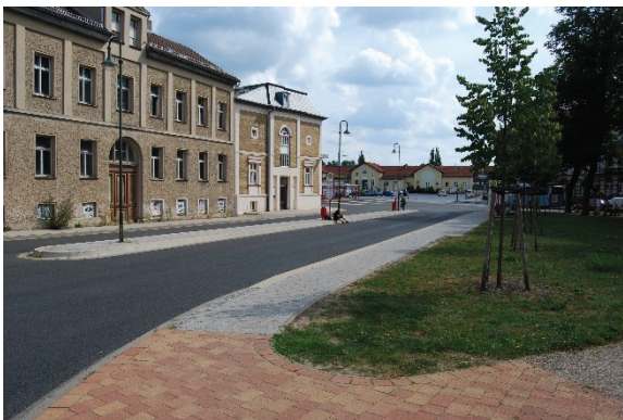
Abb. 20: Eingefärbte Rechteckbetonplatten im Bereich der Buseinfahrt
