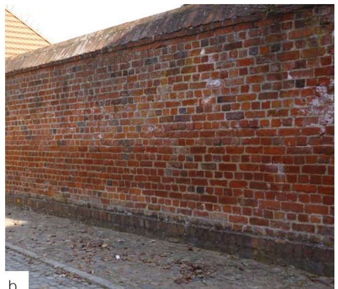
Abb.a: Die Tilly-Schanze heute an der Spornholzer Straße von der Woldegker Straße aus, von S nach N Abb.b: Der übliche Mauerverband (Binder- Läufer - Läufer - Binder = märkischer Verband) ist an den Zwingern der Stargarder Tors östlich ausgebeSSERT mit einer Läufer-Schicht und einer Binderschicht im Wechsel (Kreuzverband)
