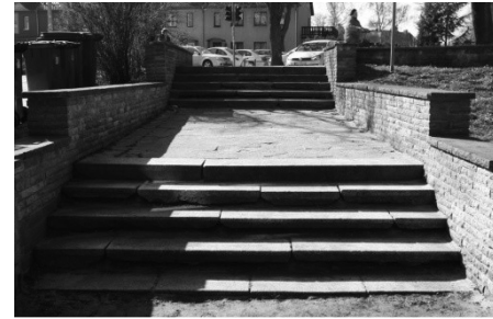
Abb. 130 Treppe am Eingang Knieperdamm 10, 2012
