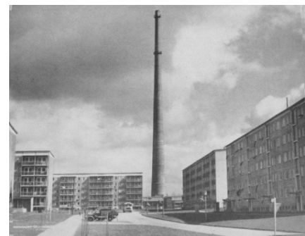
Abb. 86 Knieper West mit Heizwerk um 1965
