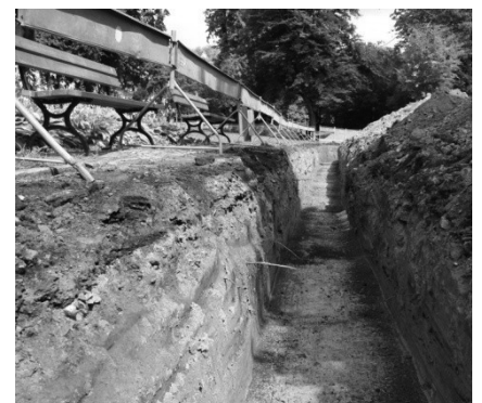
Abb. 85 Baustelle für den Leitungsbau, 2012
