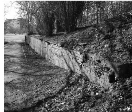
Abb. 127 Stützmauer an der Straße Hinter der Brunnenau, 2012
