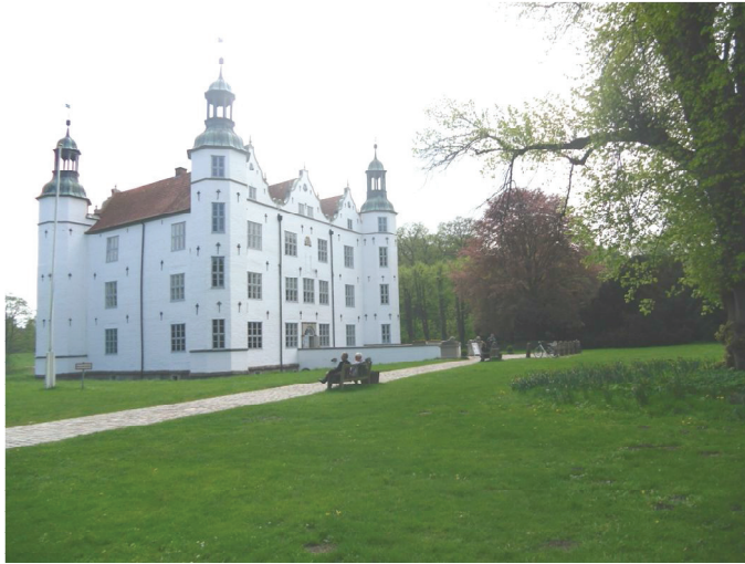
Abbildung 14: Foto in Richtung Süden - Schlosseingang; Mai 2013; Quelle: Eigene
