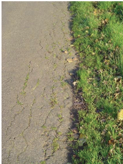
Abbildung 14: Schäden ländlicher Wege; brüchige Kanten (li.) und Schlaglöcher (re.) durch hohe Lasten, Unterdimensionierung und unzureichende Tragfähigkeit des Untergrundes (33)
