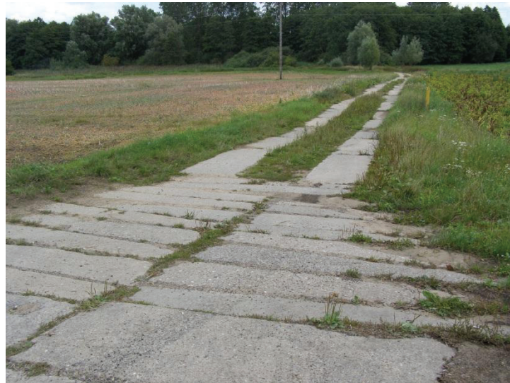
Foto 2: Felderschließungsweg aus Betonplatten als Spurbahn, bei Altentreptow
