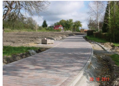
BOV Wokuhl – ländlicher Wegebau vollflächig aus Betonsteinpflaster
