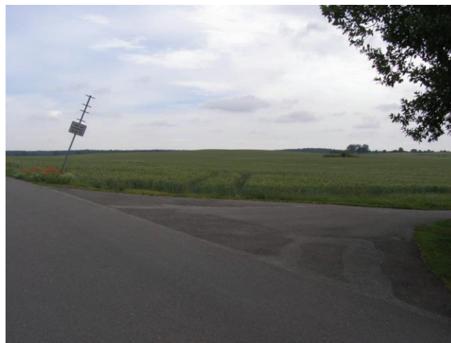
Foto 6: BOV Altenhagen, ländlicher Weg mit Asphaltbeton ausgebaut, hier mit Verbreiterung im Kreuzungsbereich
