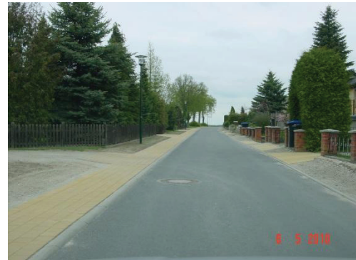
BOV Golchen – öffentl. Dorferneuerung Dorfstraße vollflächig mit Asphaltdeckschicht Gehweg mit Pflasterdecke
