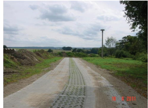
BOV Wagun – ländlicher Wegebau Spurbahn aus Pflasterstein
