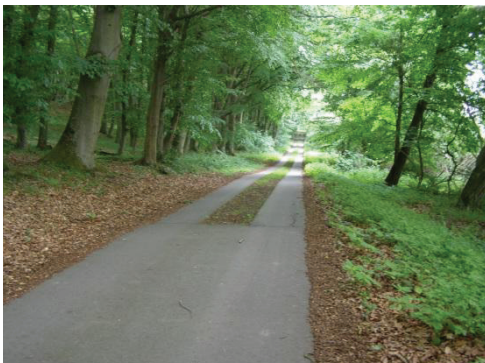
BOV Golchen – ländlicher Wegebau Spurbahn und vollflächig mit Asphaltdeckschicht
