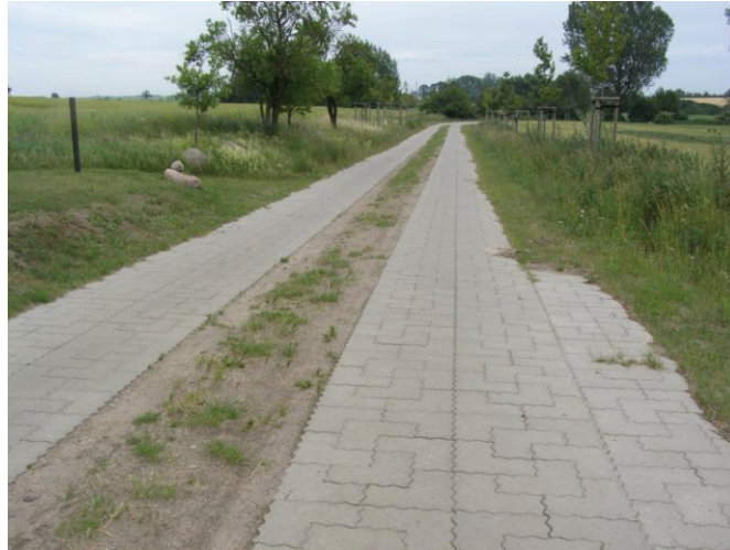
Foto 5: BOV Daberkow, ländlicher Weg als Spurbahn mit Verbundpflaster ausgebaut
