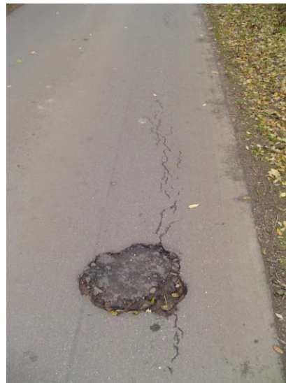
Abbildung 14: Schäden ländlicher Wege; brüchige Kanten (li.) und Schlaglöcher (re.) durch hohe Lasten, Unterdimensionierung und unzureichende Tragfähigkeit des Untergrundes (33)
