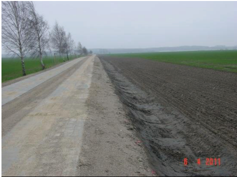
BOV Nossendorf – ländlicher Wegebau Spurbahn aus Pflasterstein
