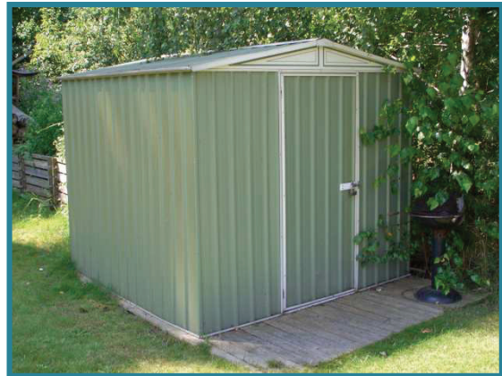
Abbildung 7: Gerätehaus aus Wellblech, Quelle: Eigene [27.07.2012]
