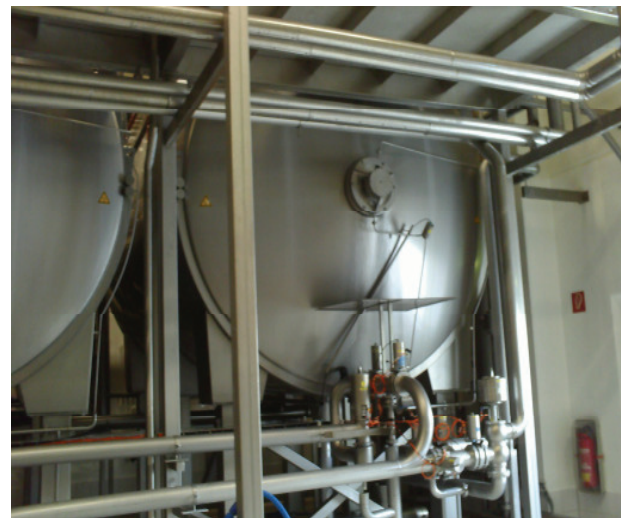
Abb. 7: Käsefertigerbühne unterhalb: unterer Teil eines Käsefertigers sichtbar
