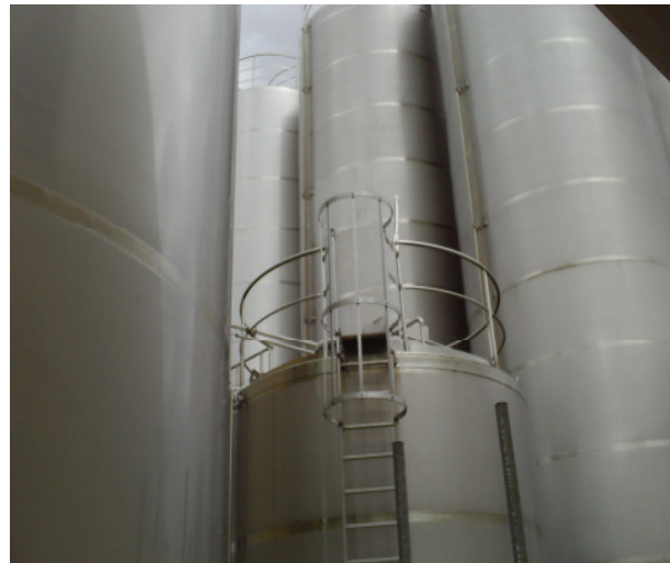
Abb. 5: Standardisierungstanks außerhalb des Tanklagers der Käserei Altentreptow
