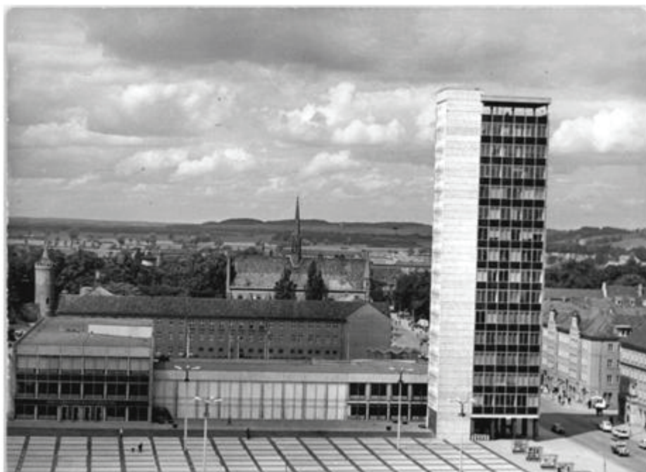
Abb. 1 Ansicht auf die Südseite des HKB
