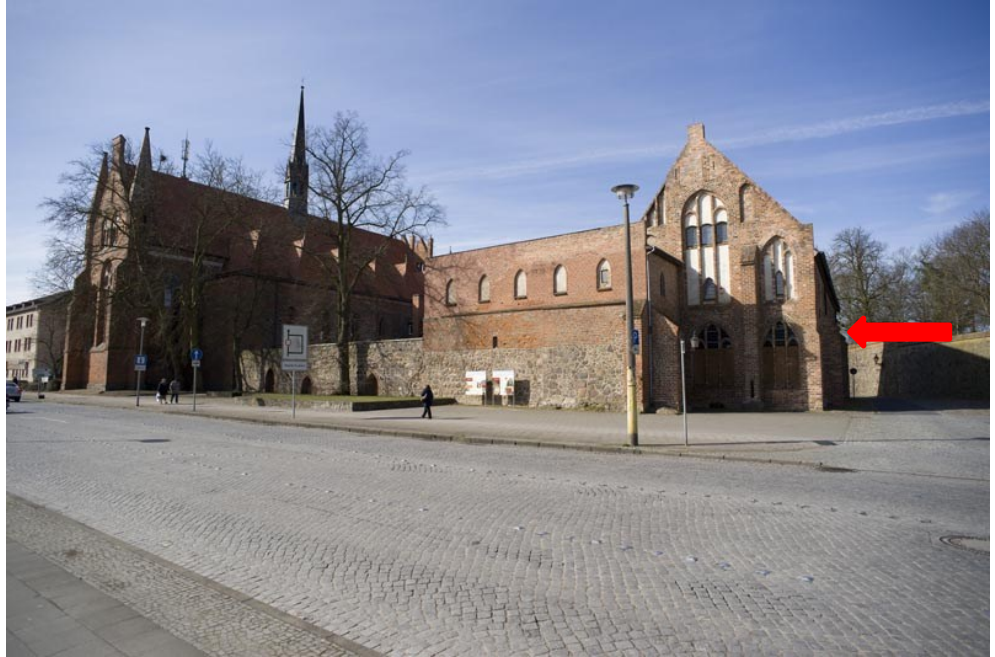
Abbildung 3: Nordflügel, ehemaliges Refektorium, Ostgiebel (Quelle: Internet, http://www.filmlocation-mv.de/bilder_locations/630/630-1286201145-0.jpg )
