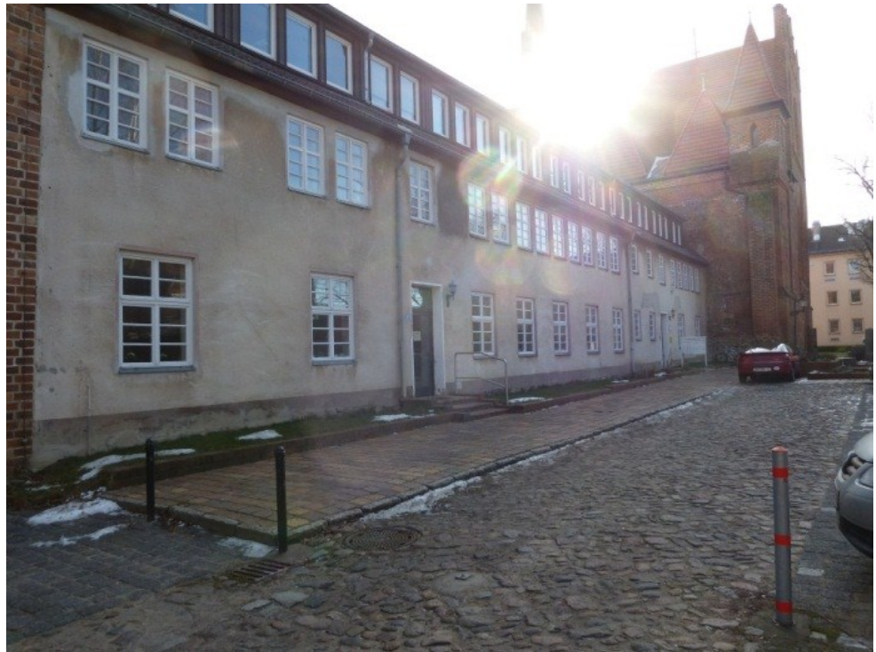
Abbildung 12: Westfassade Regelgebäude (Quelle: Naruhn, 2012)
