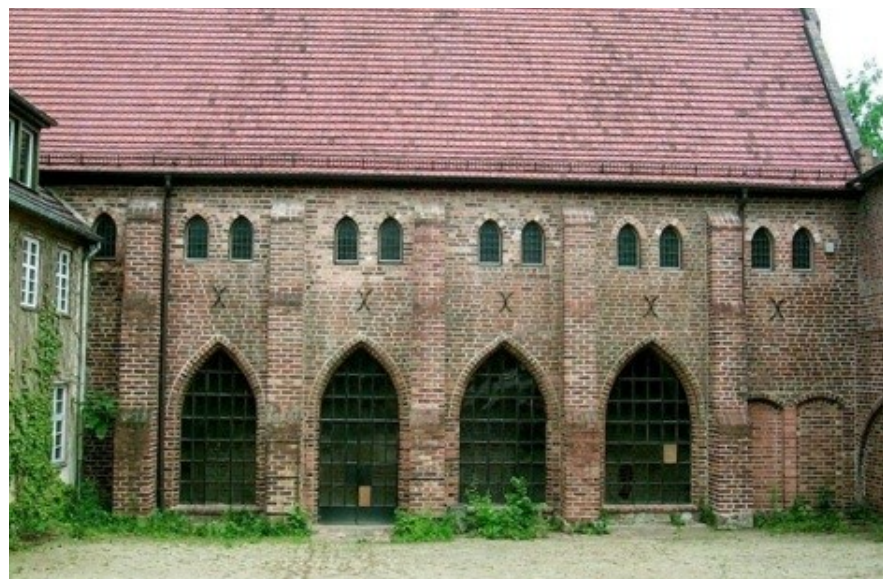
Abbildung 6: Nordflügel, ehemaliges Refektorium, Südfassade (Quelle: Internet http://bricks.eurob.org/img/27124_20_Kloster_Ref_Sued.jpg )
