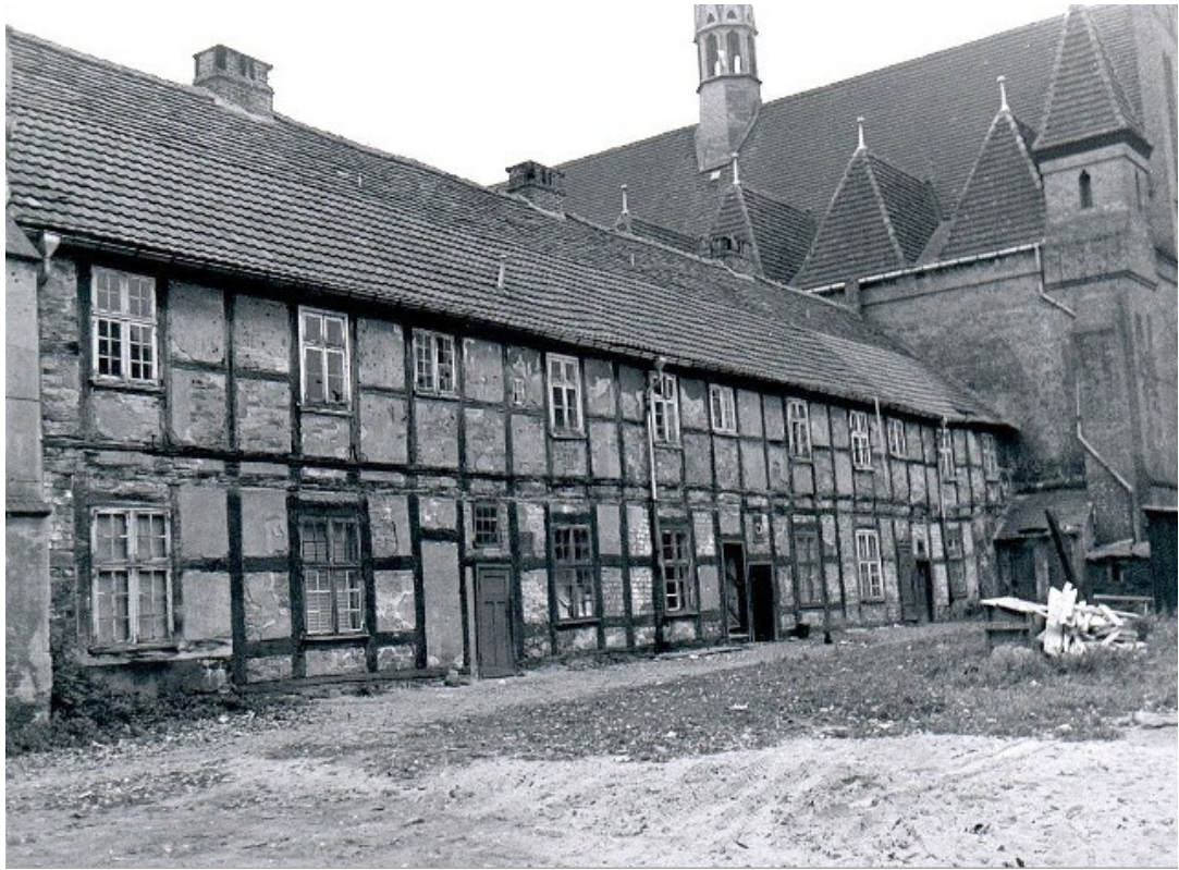
Abbildung 26: Westfassade Regelgebäude um 1969 (Quelle: Internet http://bricks.eurob.org/img/27104_15_KlosterRegelgebäudeWestseite.jpg )
