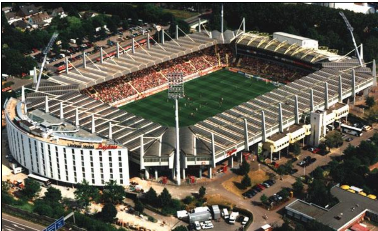
Abbildung 63 Die BayArena in Leverkusen mit einem Hotel am Stadionkörper
