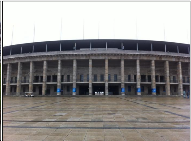
Abbildung 107 Freiraum zwischen dem Olympischen Tor und dem Olympiastadion in Berlin
