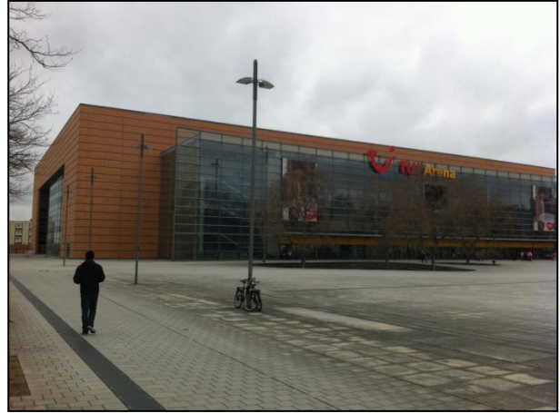
Abbildung 111 Mastleuchten am Rand der Expo-Plaza in Hannover
