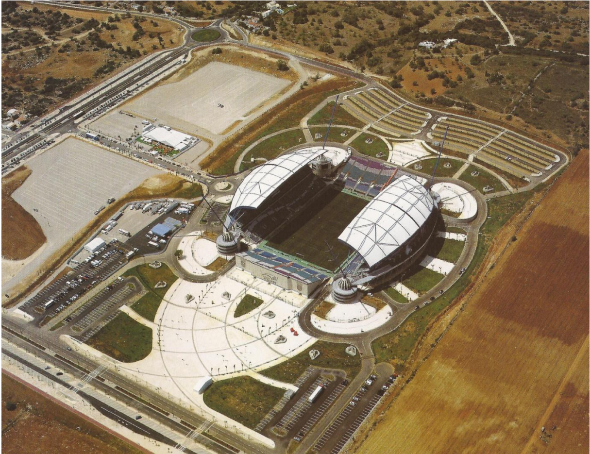
Abbildung 92 Das Estádio Algarve in Faro/Loulé (Portugal)
