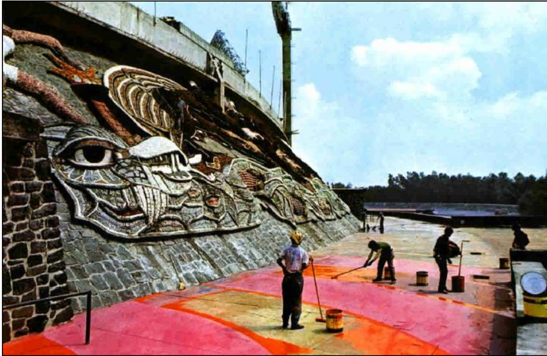
Abbildung 33 Verzierte Fassade und Markierungsarbeiten auf dem Vorplatz
