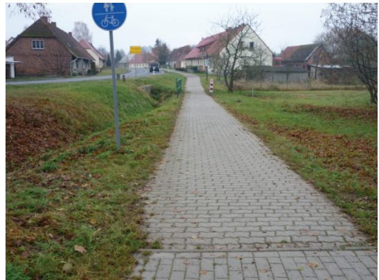
Abbildung 17 Radweg mit Betonrechteckpflaster in Vietgest
