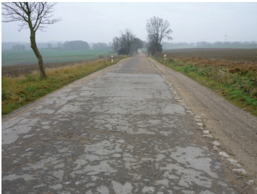
Abbildung 21 asphaltierte Kopfsteinpflasterstrecke bei Bansow
