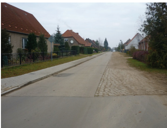
Abbildung 16 Radweg in Roggow mit Betonrechteckpflaster
