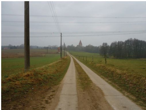
Abbildung 34 Betonspurbahn bei Reinshagen
