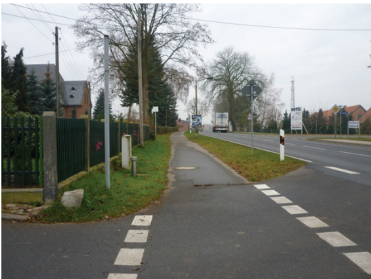
Abbildung 15 Asphaltierter Radweg in Raden
