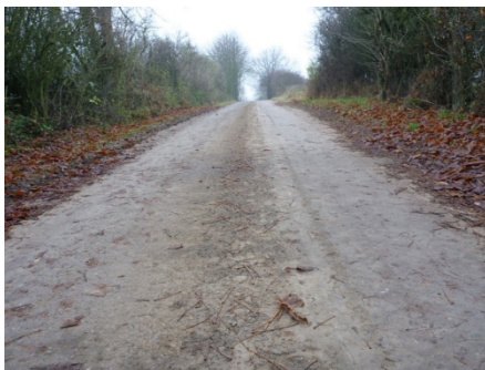
Abbildung 23 verschmutztes Kopfsteinpflaster Straße in Hinzenhagen
