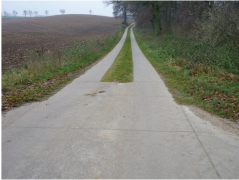
Abbildung 27 Betonspurbahn nach Mamerow
