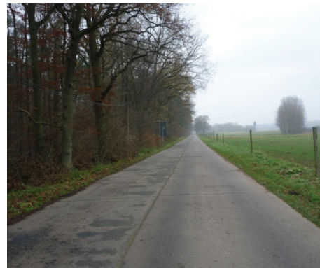
Abbildung 33 Betonplattenfahrbahn bei Reinshagen
