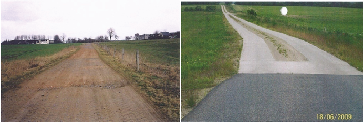
Abb. 4: Verbindungsweg von Allerstorf nach Alt Guthendorf (M 103) vor (links) und nach (rechts) der Sanierung (Quelle: Stadtbauamt Marlow)
