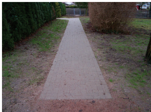
Abb. 41 neues Betonpflaster
