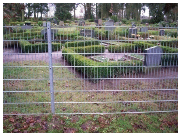
Abb. 38 Stahlgittermattenzaun
