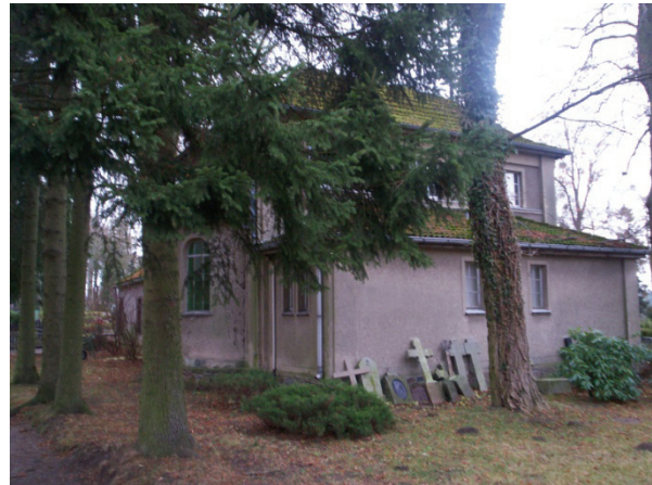
Abb. 39 Trauerhalle- Blick von Südwesten
