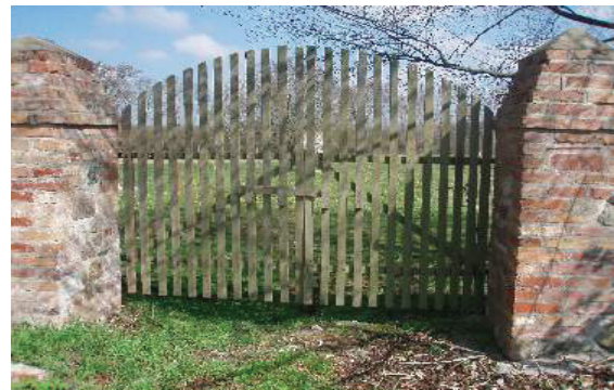
Abbildung 12: Nördliche Mauer mit Holztor
