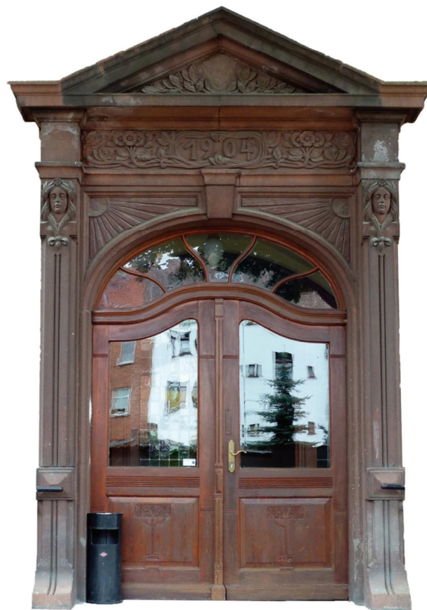
Abb.5: Eingangportal Logengebäude (Ostseite)
