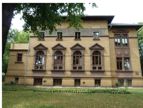
Abb.23: Südansicht des Logengebäudes
