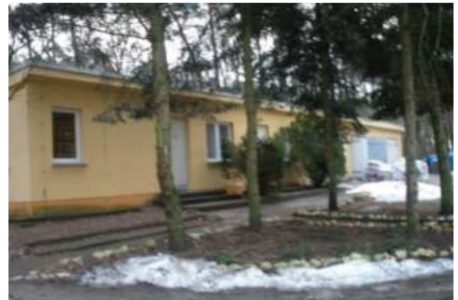
Abb. 16 Bungalow an der Hoteleinfahrt
