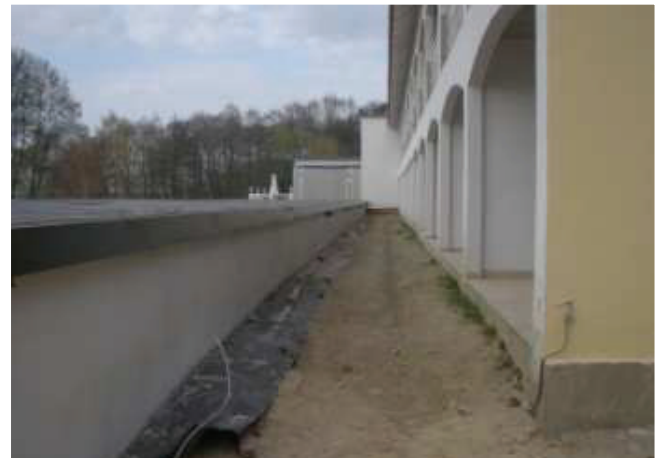
Abb. 26 links Loggien Bettenhauses 2, rechts Dach Wellnessgebäude
