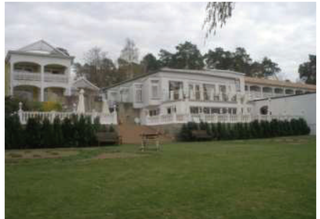
Abb. 22 Terrassen am Ufer
