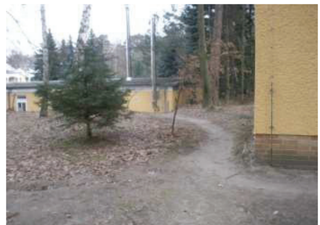
Abb. 13 Trampelpfad vom Trafo zum Wirtschaftsgebäude
