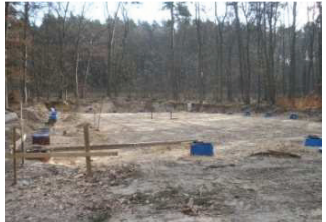
Abb. 18 Tennisplatz im Bau
