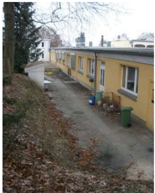
Abb. 12 südliche Seite des Wirtschaftsgebäudes
