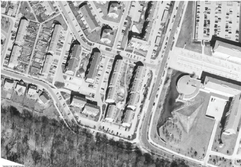
Abbildung 28: Baufeld Lindenberg Süd (Aufnahmenummer Mi29 bis Mi31)
