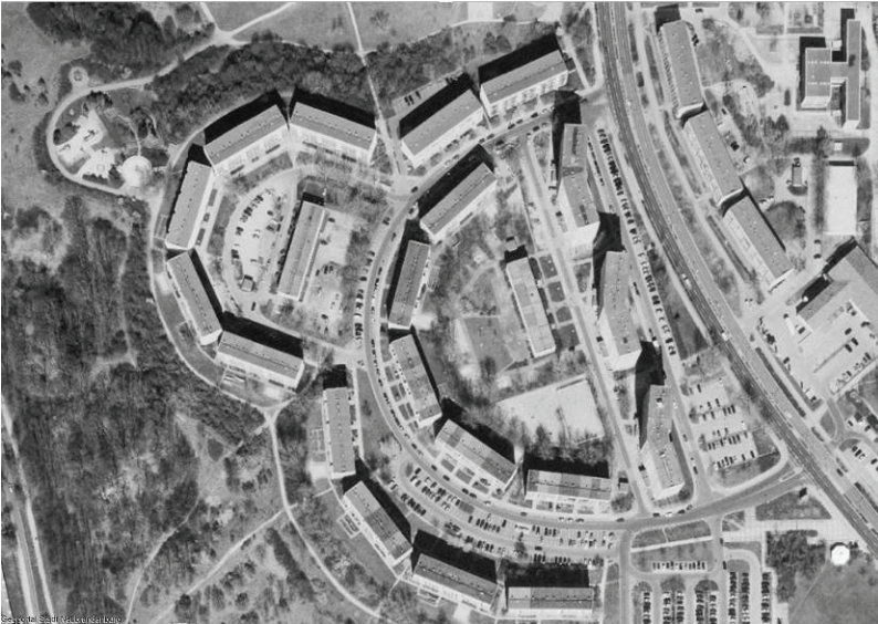
Abbildung 27: Baufeld 'Schweineohr' Oststadt (Quelle: Geodatenportal Neubrandenburg, 2011)
