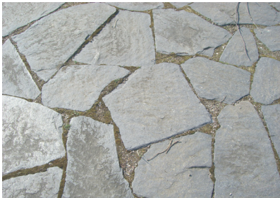
Abb. 16: unregelmäßige Theumaer Schieferplatten auf dem Plateau, Foto: Dupke, 2011
