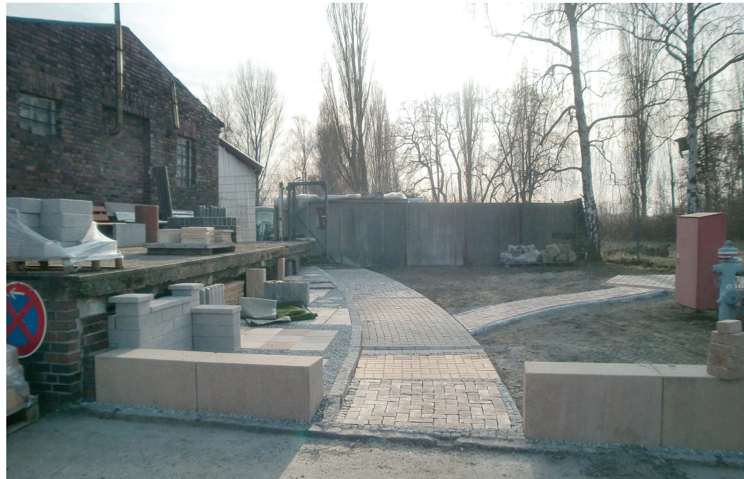
ABB. 5 STAND NACH ERSTEN ARBEITEN IM MÄRZ 2011
