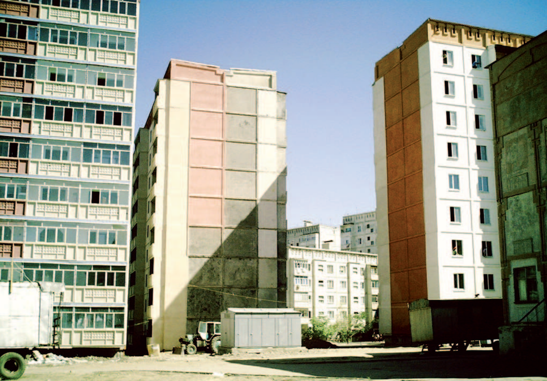
Abb.1 Wohnblöcke eines Mikrorajon in Bishkek(lizenzbefreit von Wikimedia Commons, Urheber: Nikolaus)
