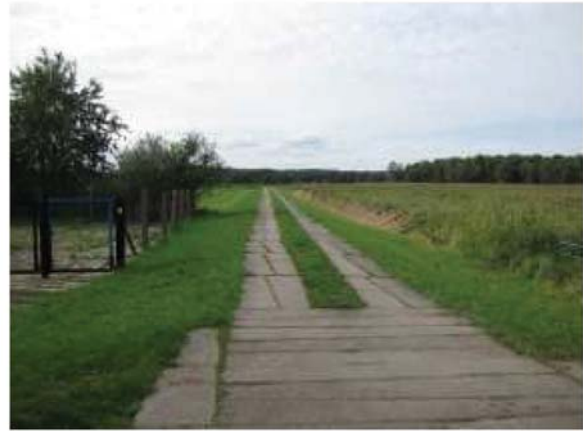
Abb. 17: Betonspurplatten bei Warsin
