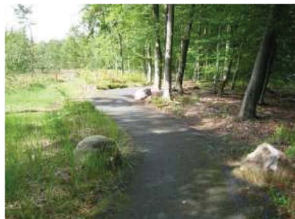
Abb. 7: Radweg mit Tränkdecke bei Torgelow
