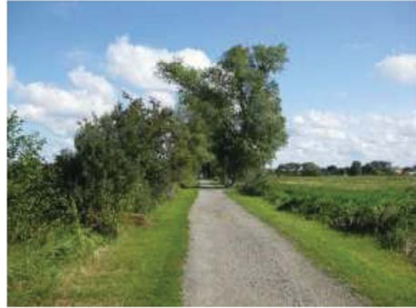
Abb. 14: Wassergebundene Wegedecke
