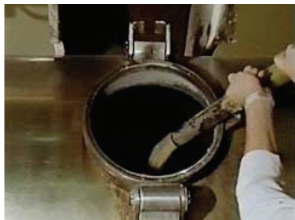
Abb. 5: Kochanlage beim Befüllen mit Zuckerlösung
