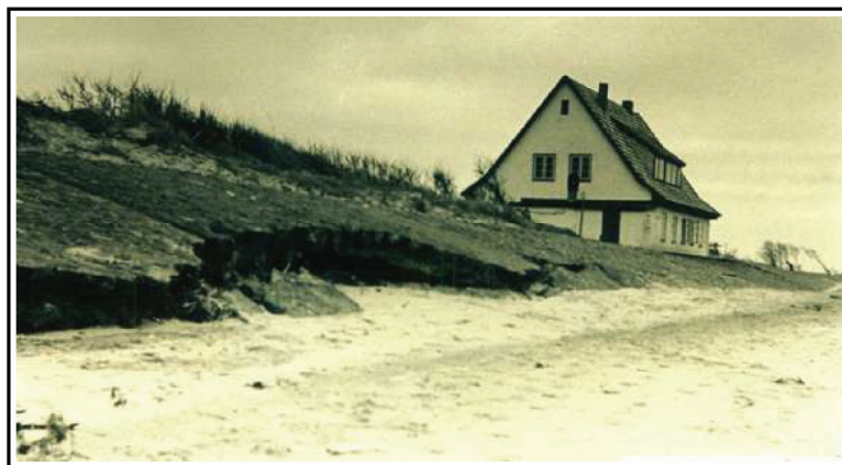
Abb. 101: Haus Cen mit zertstörtem Deckwerk nach Hochwasser 1954 - Quelle: Küstenschutz von früher bis heute Gebiet Warnemünde/Ost bis Markgrafenheide
