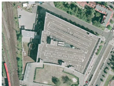
Abbildung 31 Flachdach mit Parkflächen im Orthophoto
