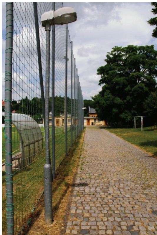
Abb. 24: Zufahrt- und Wegbeleuchtung
