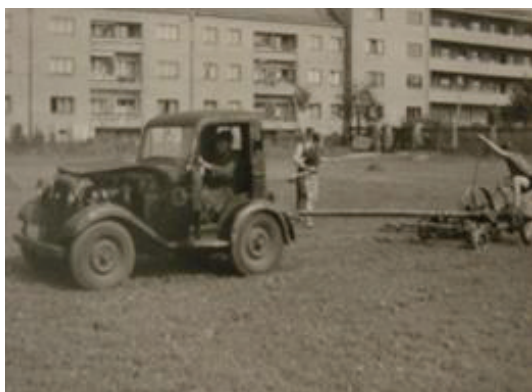
Abb. 17: Die Rasenpflege ging in den 1950er Jahren mit aus heutiger Sicht geradezu urtümlichen anmutenden Fahrzeugen vonstatten. (Blick in Richtung Sportplatzeingang)
