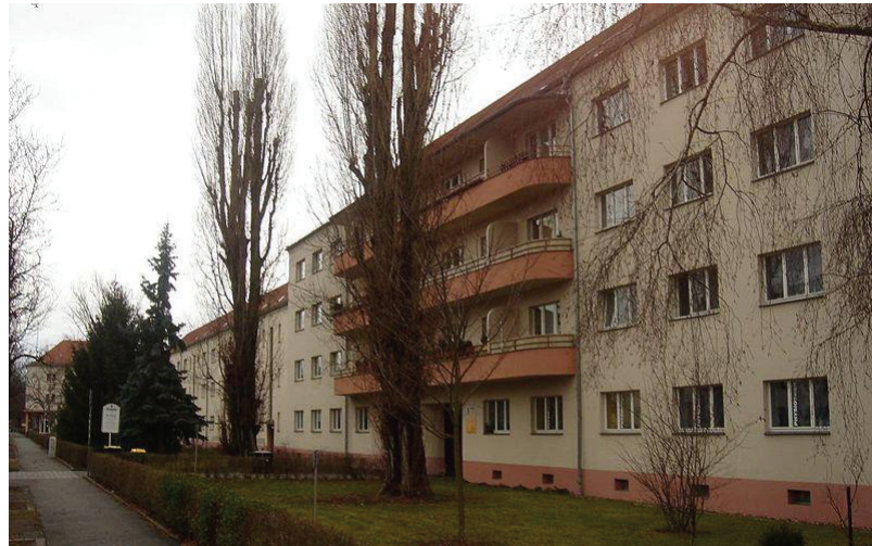
Abb. 9: Gebäudezeile Achener Straße
