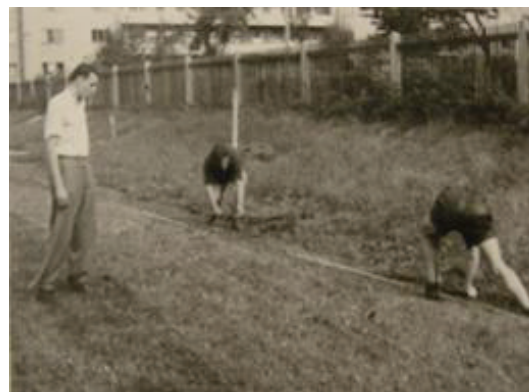
Abb. 16: Umbau des Sportplatzes in den 1950er Jahren
