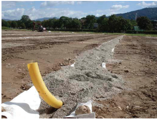
Abb. 31: Dränstrang mit Vlies, Dränrohrleitung und Dränpackung
